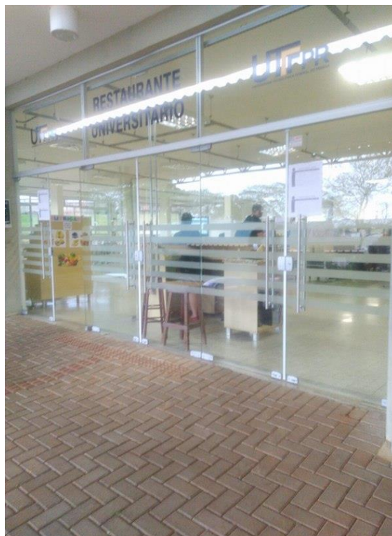
Figura 83 - Porta de acesso do restaurante universitário Fonte: Acervo do autor (2016).
