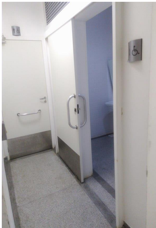
Figura 89 - Porta de acesso ao sanitário, com 0,95 m de largura Fonte: Acervo do autor (2016).
