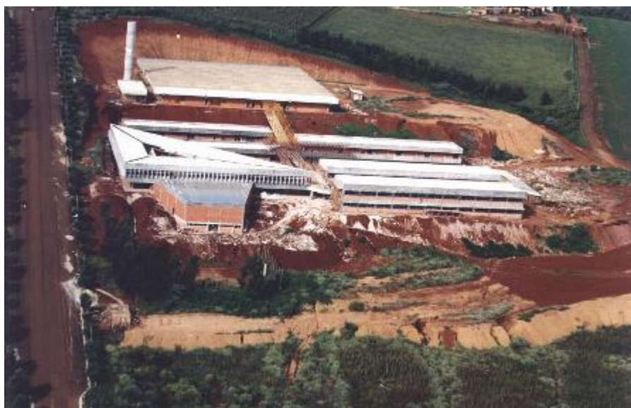
Figura 60 - Fase de construção do CEFET - PR. Fonte: UTFPR-PB (2011).
