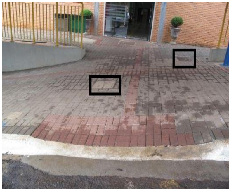
Figura 80 - Tampa de concessão nivelada com o piso e guia rebaixada com piso tátil alerta e direcional Fonte: Acervo do Autor (2016).
