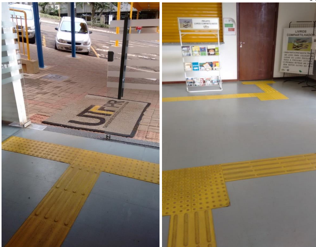
Figura 71 (esquerda) - Piso tátil alerta e direcional na entrada do bloco W
