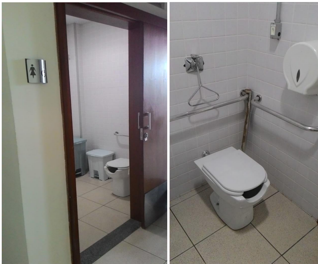
Figura 77 (esquerda) - Presença de sanitário acessível com 0,95 m com porta de correr e símbolo representativo de sanitário
