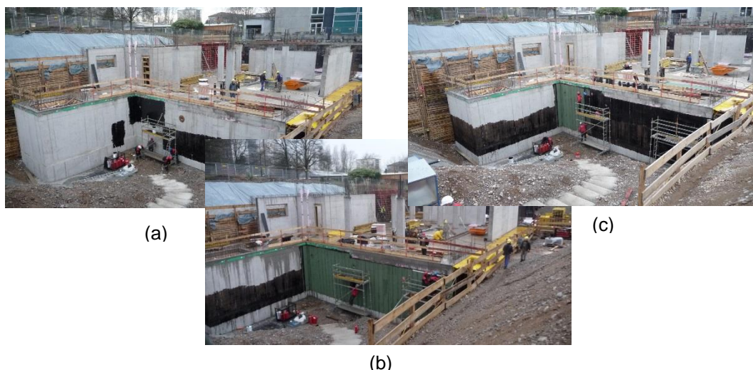
Figura 15: (a), (b) e (c) Impermeabilização externa – Clínica Universitária Fonte: Autoria Própria (2014)
