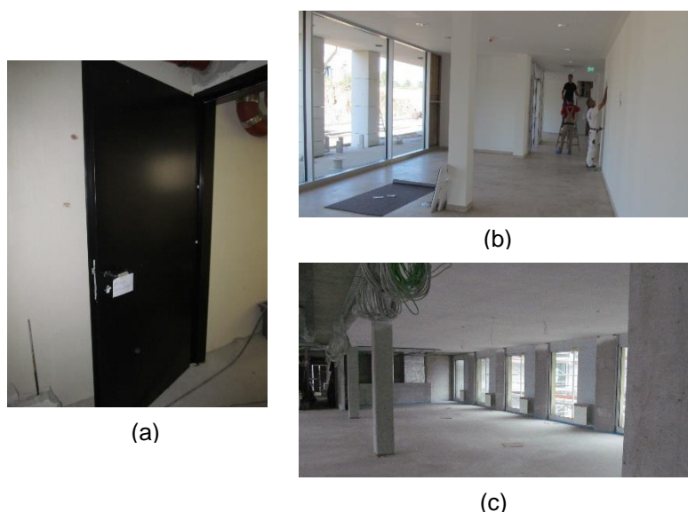
Figura 16: (a) Pintura de porta, corta-fogo – Prédio Comercial, (b) Execução de pintura da parede – Prédio Comercial e (c) Emassamento de teto – Prédio Comercial Fonte: Arquivos internos Züblin (2013)
