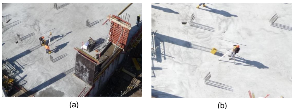
Figura 11: (a) e (b) Locação de pilares –Clínica Universitária Fonte: Autoria Própria (2014)
