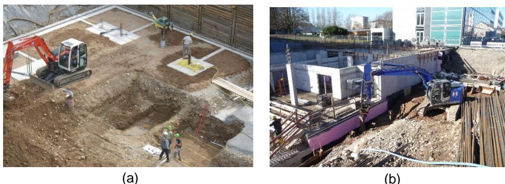
Figura 9: (a) Serviços de escavação –Prédio Comercial, (b) Serviços de compactação – Clínica Universitária
