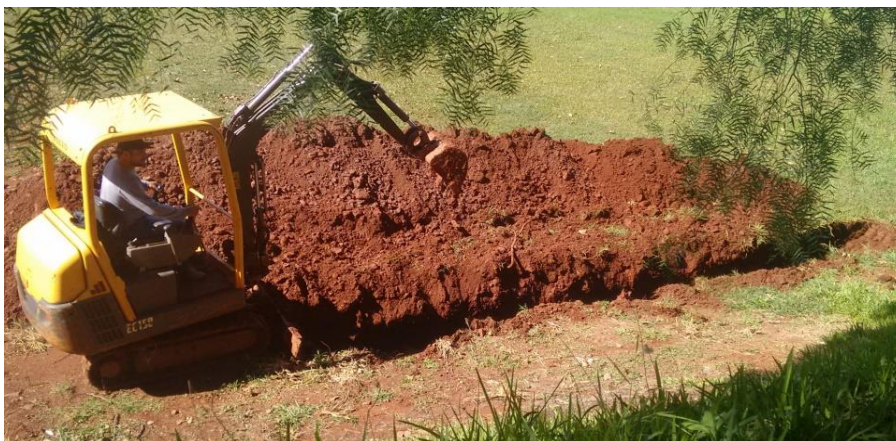
Figura 24 - Execução da vala experimental Fonte: Autoria própria.
