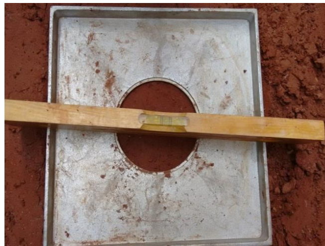
Figura 28 - Nivelamento do solo Fonte: Autoria própria.
