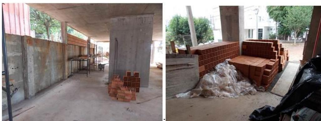
**Figura 21: Circulação e armazenamento de blocos cerâmicos**
