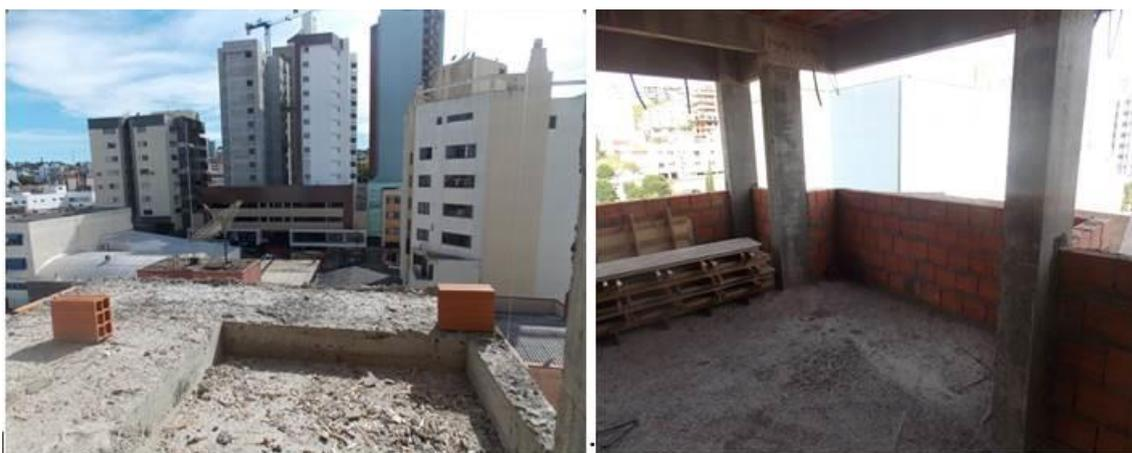
**Figura 34: Ausência de guarda corpo, e dimensões irregulares**
