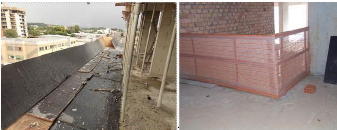
**Figura 25: Proteção contra queda em altura**
