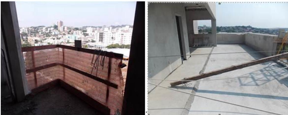
**Figura 29: Proteção contra queda em altura**
