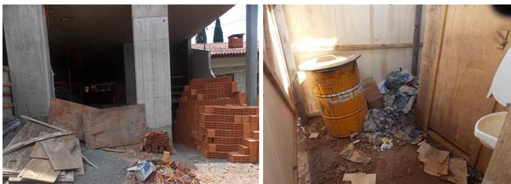
**Figura 40: Exemplo do mau condicionamento de resíduos**
