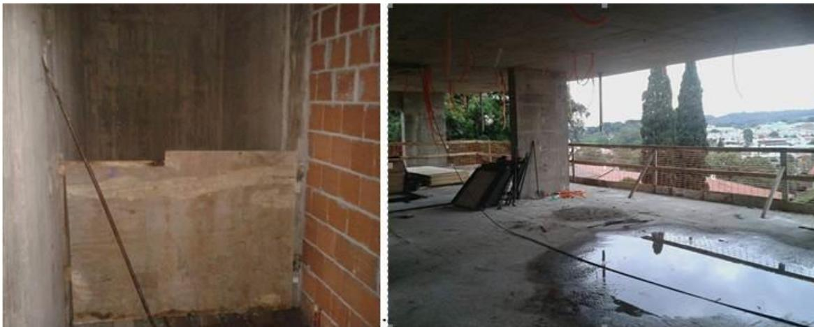
**Figura 19: Proteção contra queda de altura**
