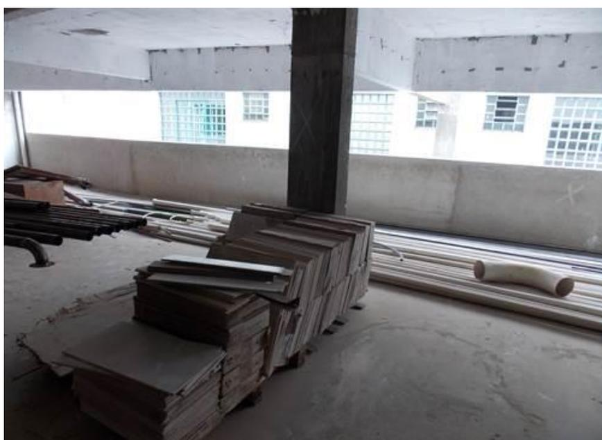
**Figura 12: Alvenaria utilizada como guarda-corpos**
