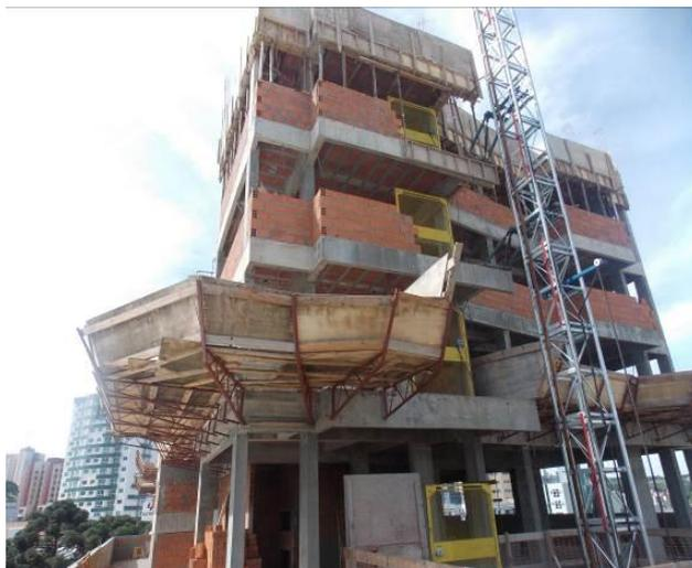
**Figura 33: Bandejas de proteção**
