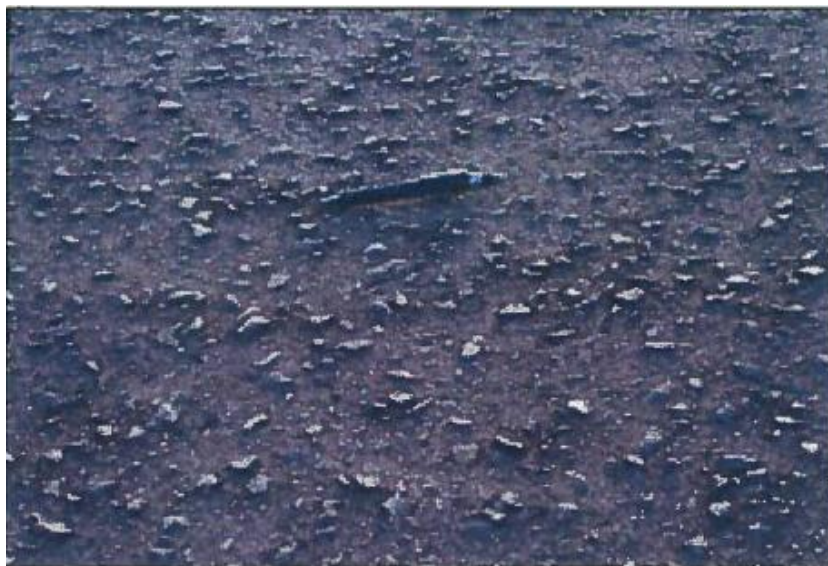
Figura 2 – Leito Asfáltico com agregados polidos FONTE: Bernucci et al (2008 apud BUCхарLES, 2014, p. 44)
