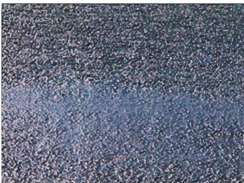
Figura 3 – Leito com exsudação do ligante asfáltico FONTE: Bernucci et al (2008 apud BUCхарLES, 2014, p.45)
