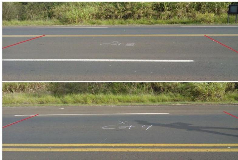
Figura 27 – Exemplo de demarcação de áreas para inventário de defeitos FONTE: Autoria Própria (2015)
