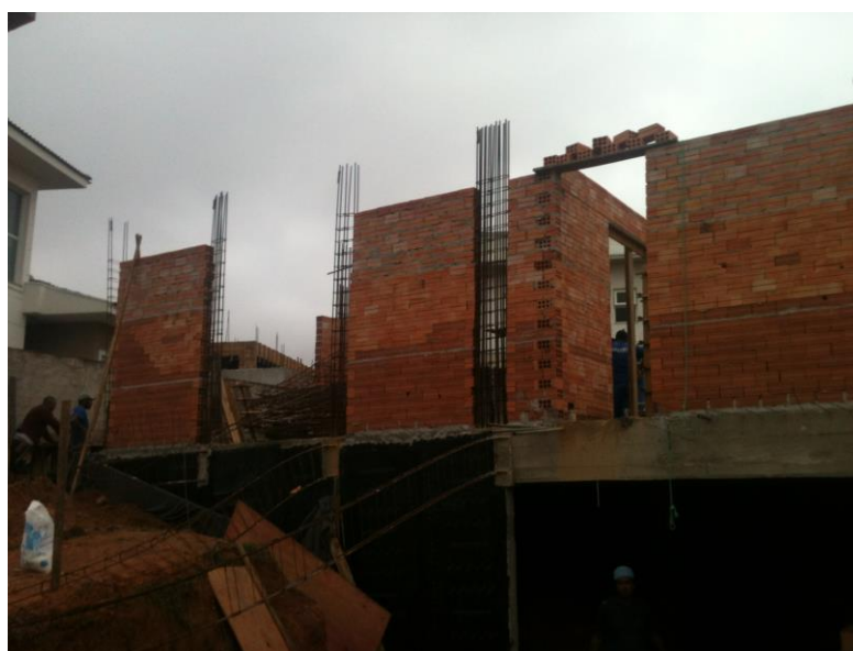
Figura 4- Método construtivo convencional Fonte: Acervo do autor, 2014.
