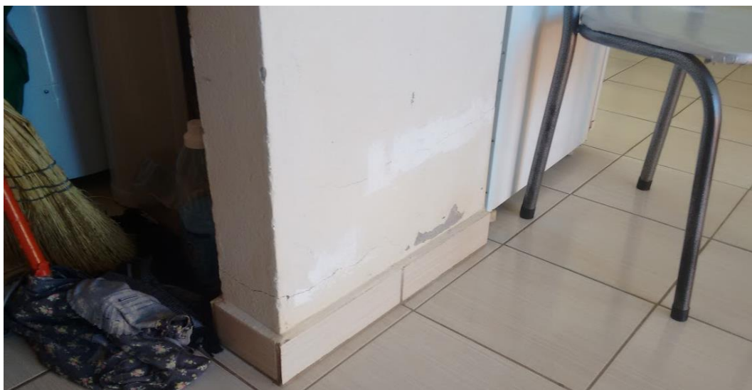
Figura 11 - Trincas observadas no estudo de caso Fonte: Acervo do Autor
