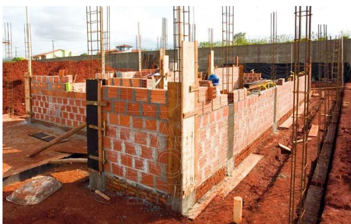
Figura 3- Método construtivo convencional Fonte: Acervo do Autor, 2014.
