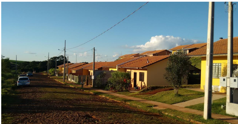
Figura 8 - Conjunto Habitacional São Roque Fonte: Acervo do Autor.
