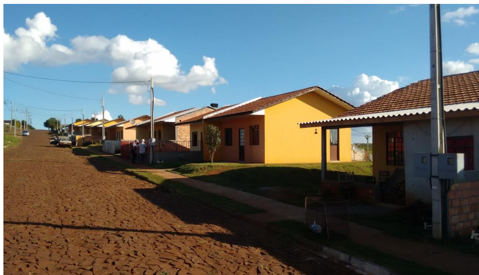
Figura 6 - Conjunto Habitacional São Roque Fonte: Acervo do Autor.
