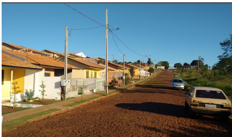
Figura 7 - Conjunto Habitacional São Roque Fonte: Acervo do Autor.
