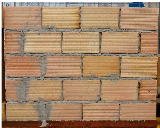
Figura 11 - Protótipo de alvenaria convencional FONTE: Autora (2015).
