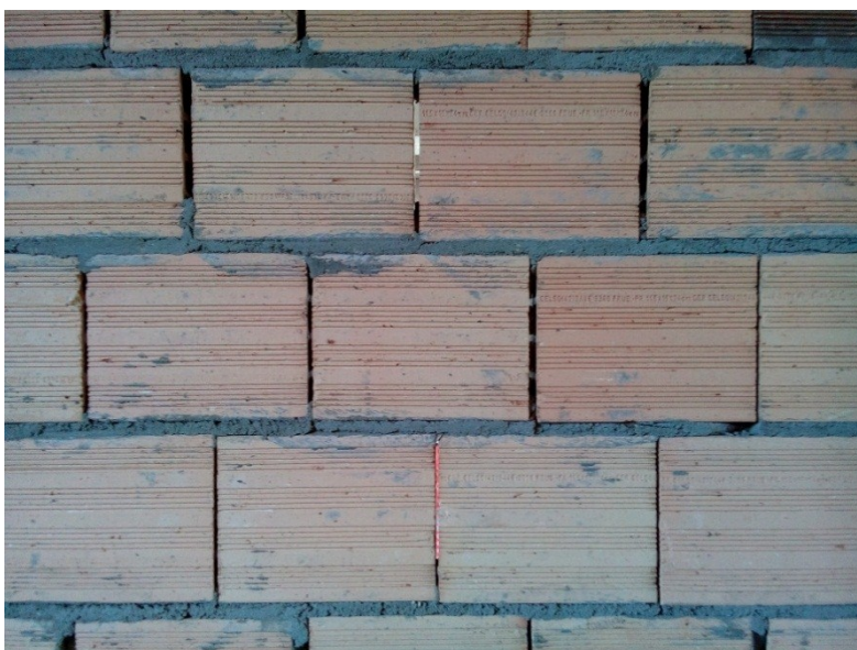
Figura 1 - Alvenaria com juntas secas FONTE: Autora, 2015.
