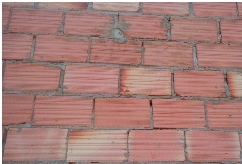
Figura 2 - Alvenaria convencional FONTE: Autora, 2015.
