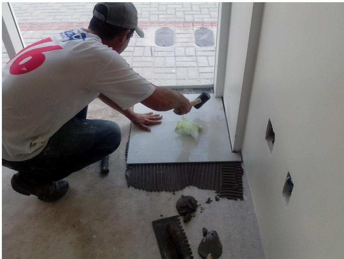
Figura 18 - Assentador acomoda a peça com martelo de borracha Fonte: Autora, 2013.
