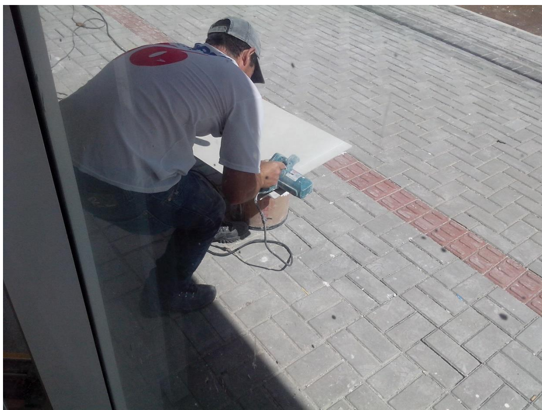
Figura 16 - Corte da peça com a makita Fonte: Autora, 2013.
