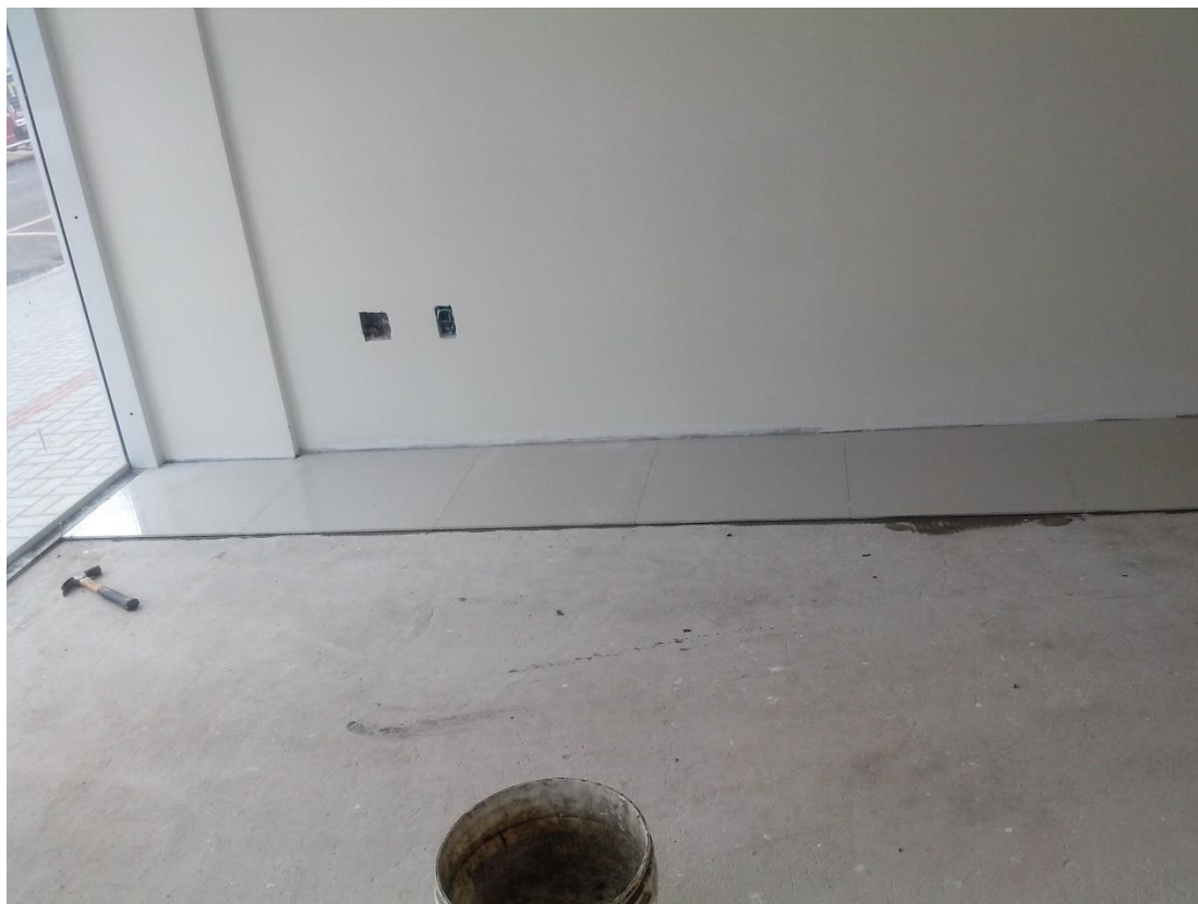
Figura 20 - Primeira fiada do revestimento cerâmico Fonte: Autora, 2013.
