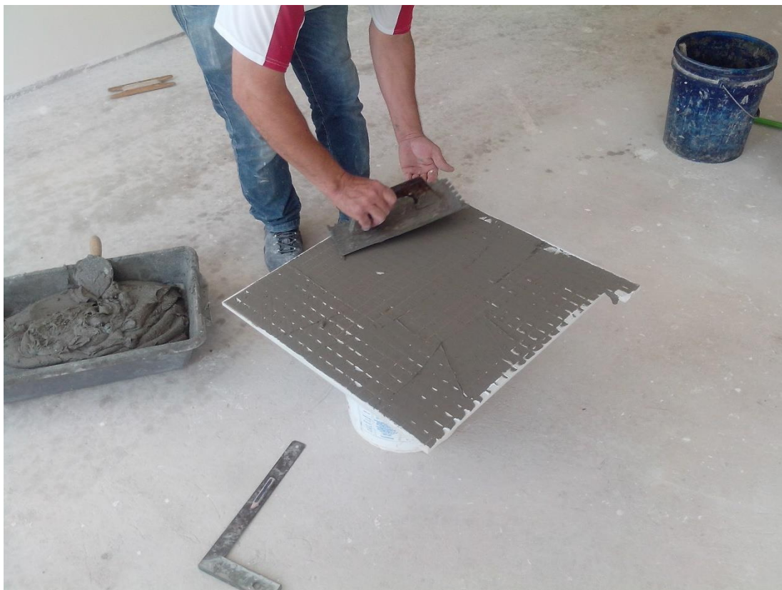
Figura 17 - Primeira peça a ser assentada Fonte: Autora, 2013.
