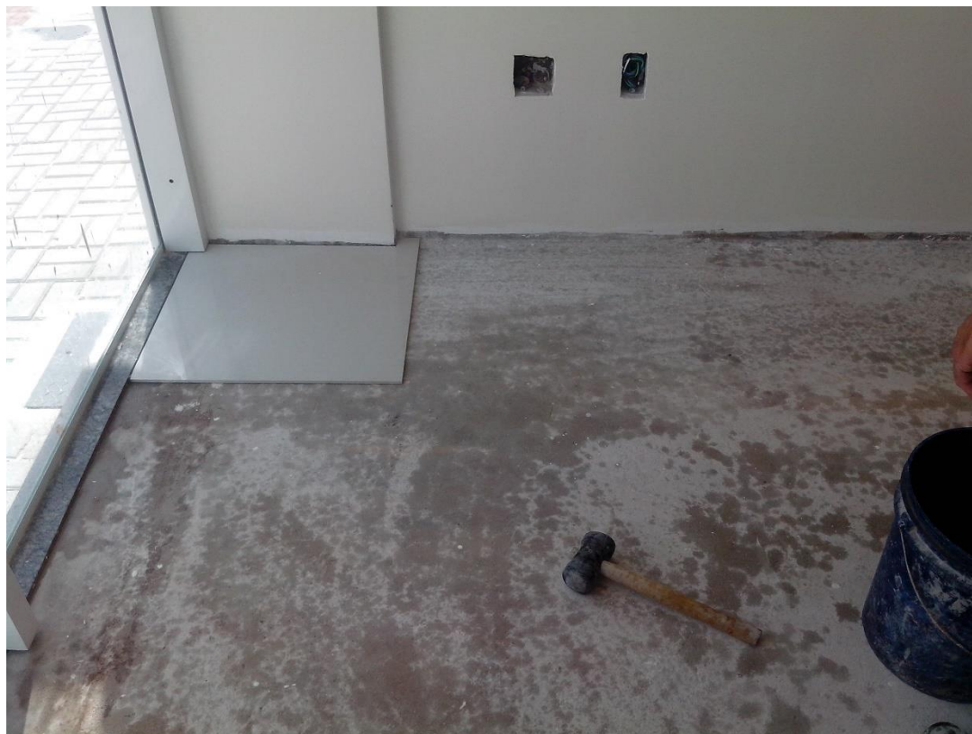
Figura 14 - Detalhe do assentamento da primeira peça Fonte: Autora, 2013.
