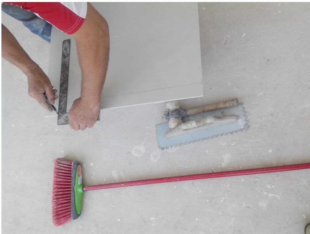
Figura 15 - Riscagem do corte a ser efetuado Fonte: Autora, 2013.
