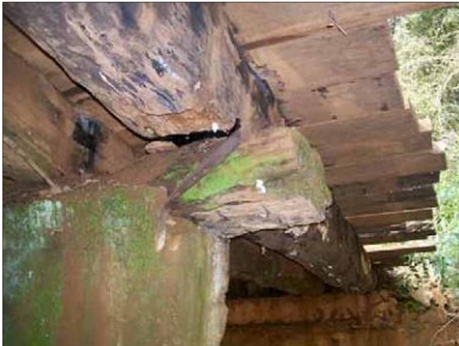
Figura 40 - Detalhe da Viga de Suspensão. Fonte - Borsatti (2013).
