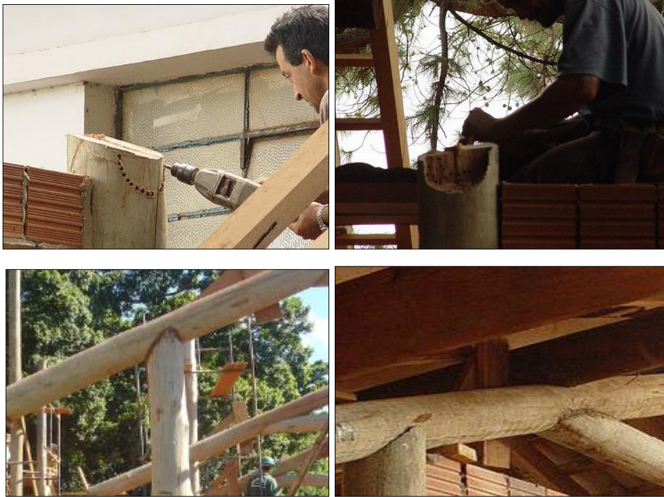
Figura 14 - Confeção da Ligação para Entalhe, de Encaixe Cilíndrico, no Topo da Peça. Fonte - Acervo dOs Autores (2013).
