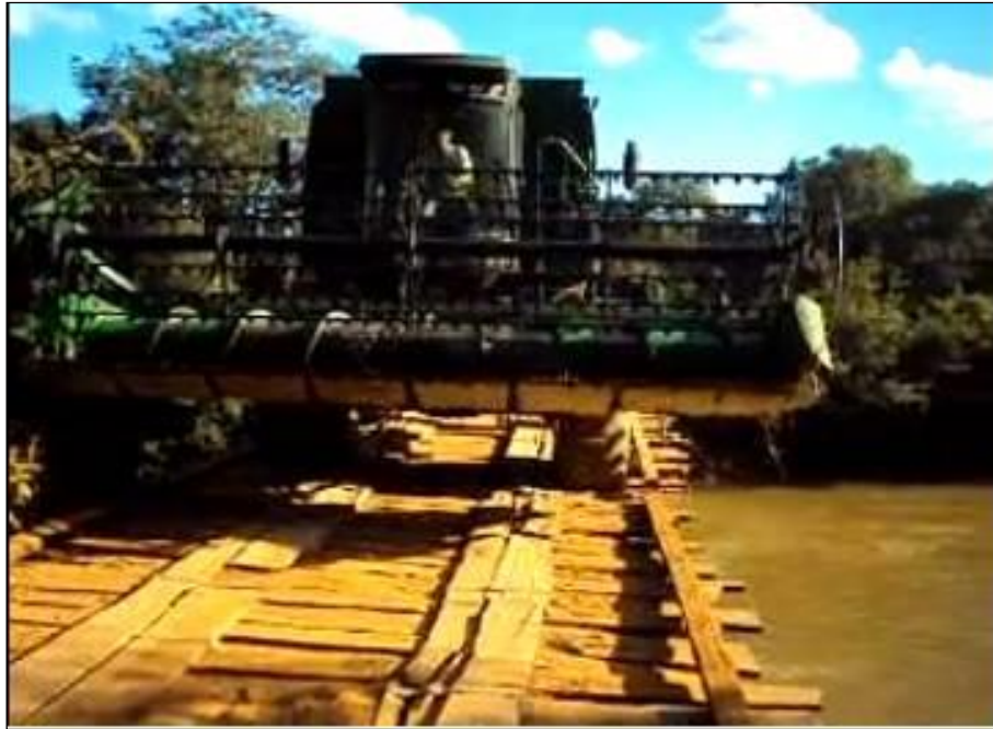
Figura 44 - Máquina Atravessando a Ponte. Fonte - Borsatti (2013).
