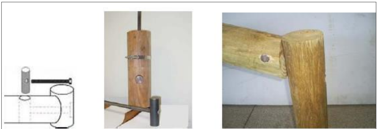
Figura 16 - Ligação Metálica com Barras Rosqueada e Pino. Fonte - BRITO (2010).
