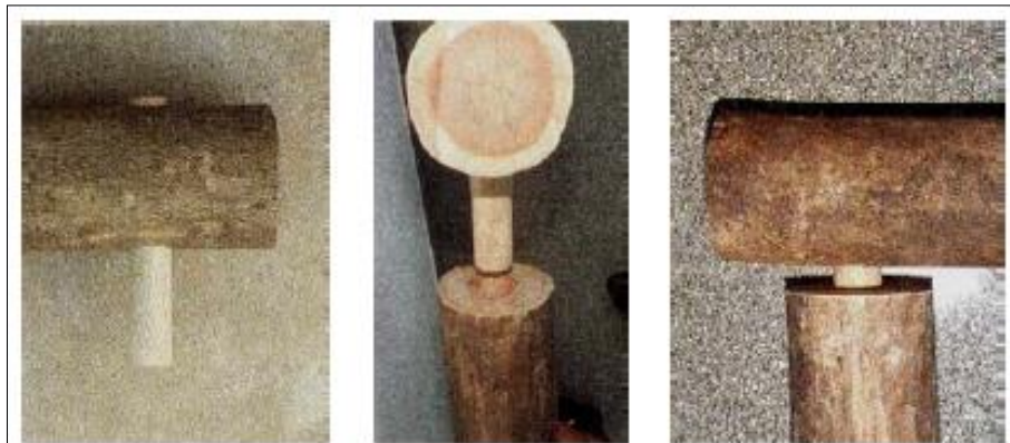
Figura 15 – Ligações por Cavilha. Fonte – PARTEL (1999).
