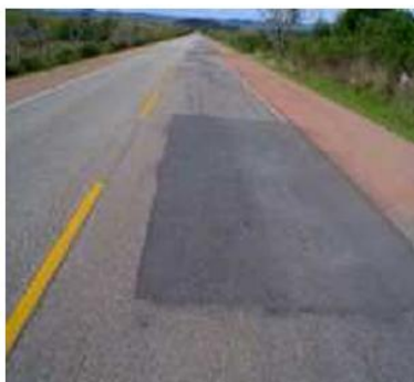
Figura 12 - Remendos Severidade 1
