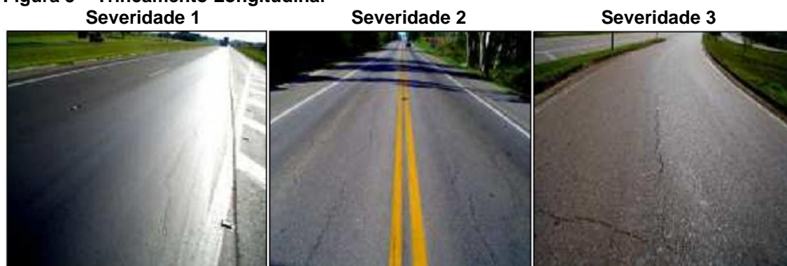
Figura 5 – Trincamento Longitudinal
