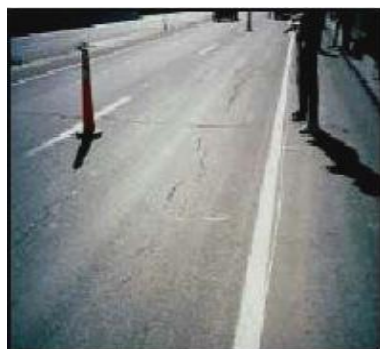
Figura 1 – Couro-de-Crocodilo Severidade 1
