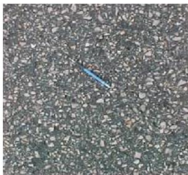
Figura 9 – Desgaste Severidade 1
