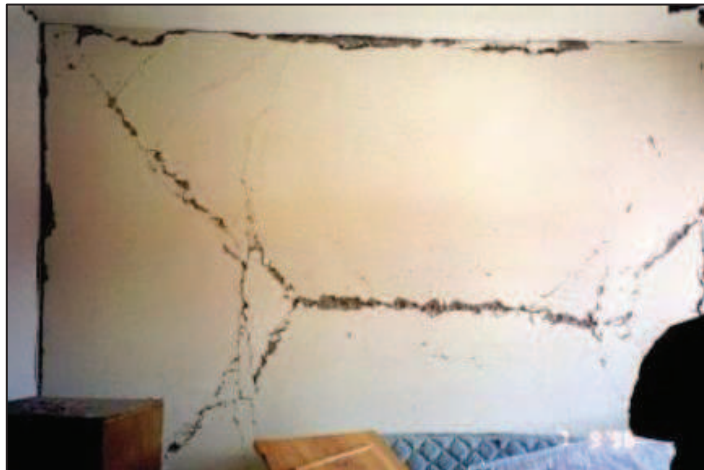
Figura 9 - Linhas de ruptura nas paredes internas. Fonte: Laranjeiras (2011).
