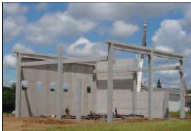
Figura 4 - Construção pré-fabricada pós 1980. Fonte: Serra et al (2005).
