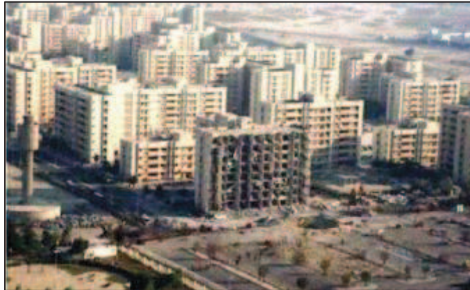
Figura 7–Khobar Towers, Arábia Saudita. Fonte: Cleland (2007).
