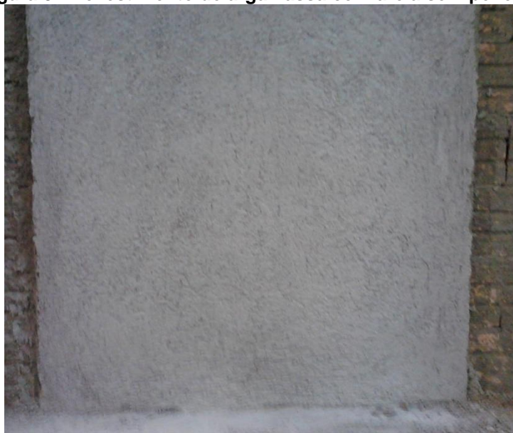
Figura 8 - Revestimento de argamassa com areia sem peneirar
