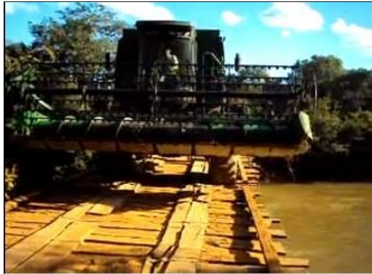
Figura 39 – Máquina atravessando a ponte
