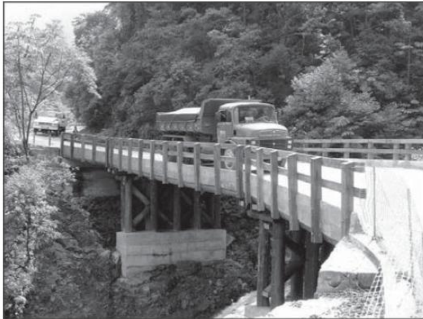
Figura 2 – Ponte em placa mista madeira–concreto (Ponte Caminho do Mar)
