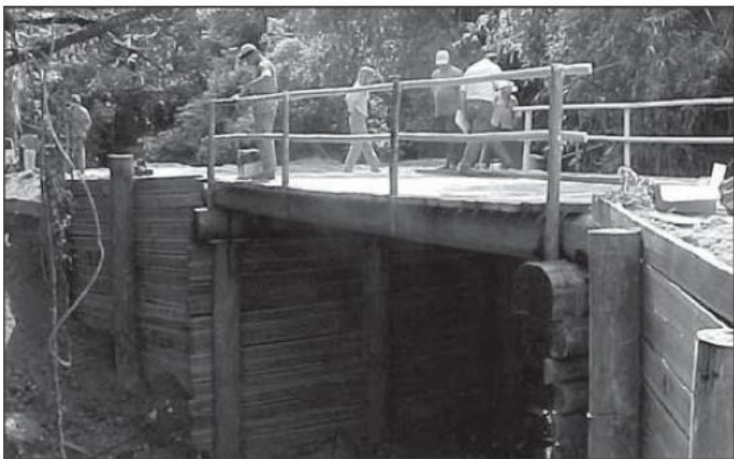
Figura 1 – Pontes em viga de madeira roliça (Ponte Estrada Floresta)
