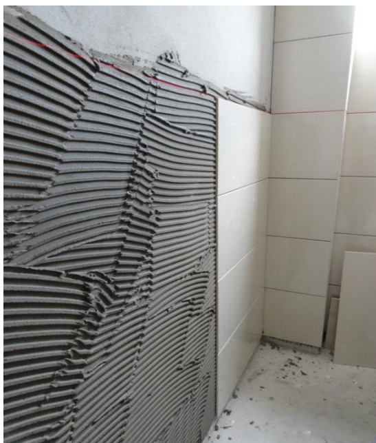
Figura 15 – Fotografia - Primeira fiada vertical pronta – Apt. “B” Fonte: Autoria própria.
