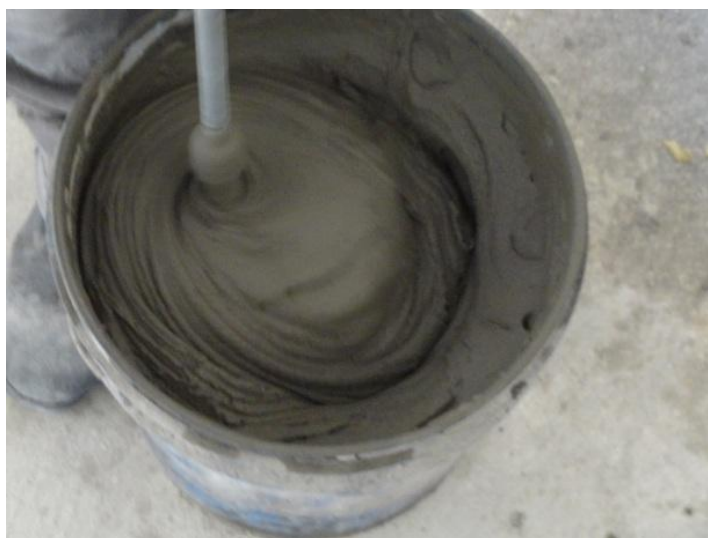
Figura 12 – Fotografia - Produção de argamassa colante Fonte: Autoria própria.
