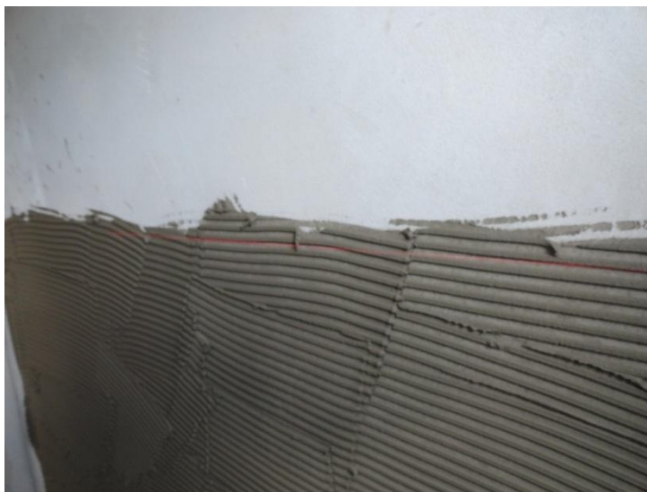
Figura 13 – Fotografia - Espalhamento da argamassa colante e linha de saída – Apt “B”
