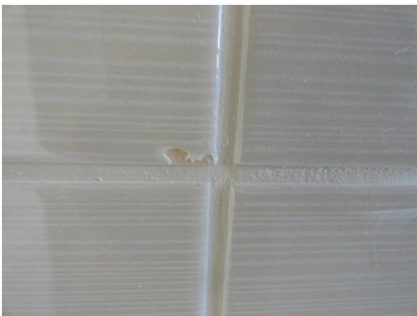
Figura 7 – Fotografia - Defeito provavelmente com origem na produção Fonte: Autoria própria.
