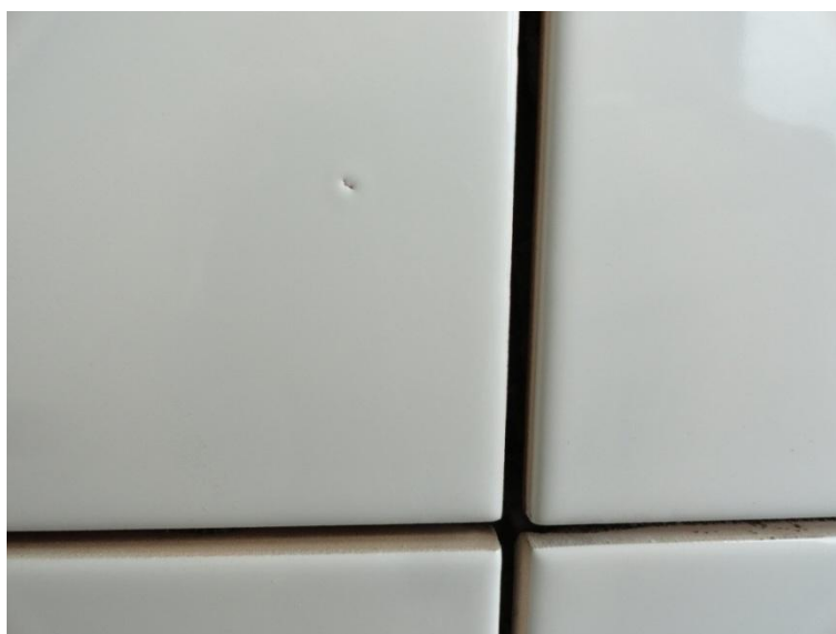
Figura 9 – Fotografia - Defeito provavelmente com origem na produção Fonte: Autoria própria.
