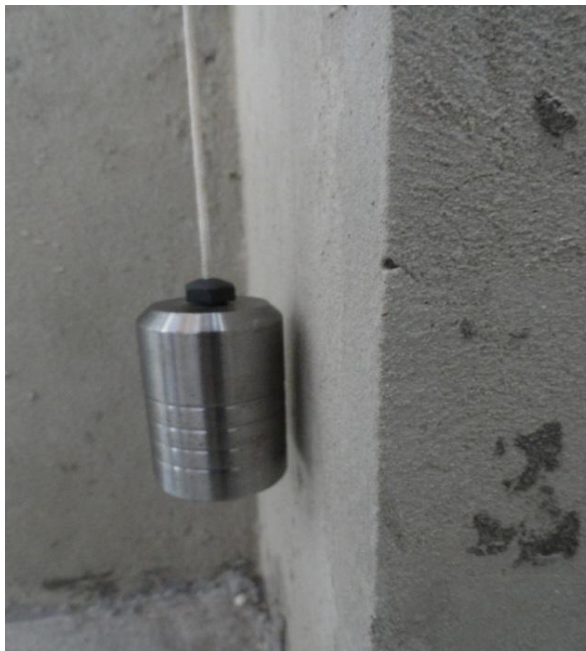
Figura 10 – Fotografia - Conferência de prumo – Apt. “C” Fonte: Autoria própria.
