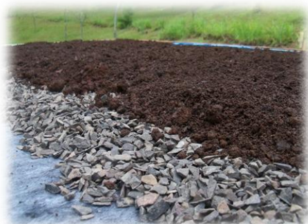
Figura 11 – Camada de terra em cima da brita e geomanta. Fonte: Autora (2013).
