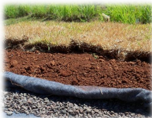
Figura 24 – Geomanta em cima da camada de brita Fonte: Autora (2013).
