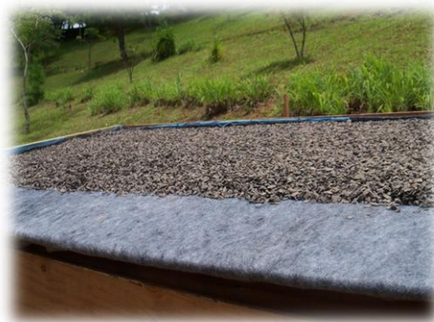
Figura 10 – Camada de pedra brita em cima da geomanta. Fonte: Autora (2013).
