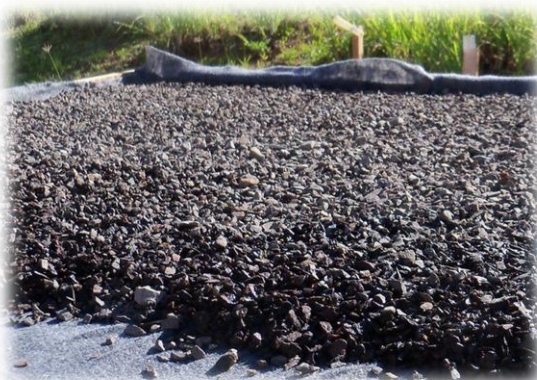
Figura 23 – Camada de brita nº 0 em cima da geomanta. Fonte: Autora (2013).
