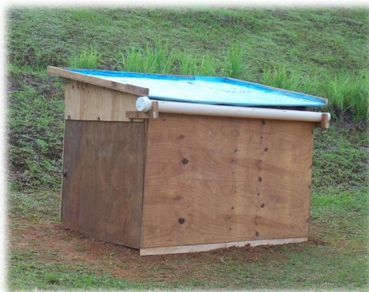
Figura 08 – Protótipo pronto com impermeabilização com lona. Fonte: Autora 2013.
