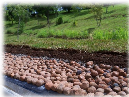
Figura 13 – Detalhe da argila expandida na faixa final da cobertura. Fonte: Autora (2013).
