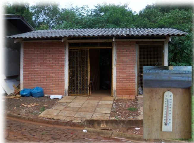
Figura 17 – Depósito de lixo reciclável com detalhe do termômetro interno.
