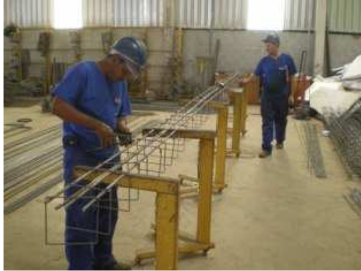
Fotografia 3 – Montagem manual das armaduras Fonte: Autoria própria
