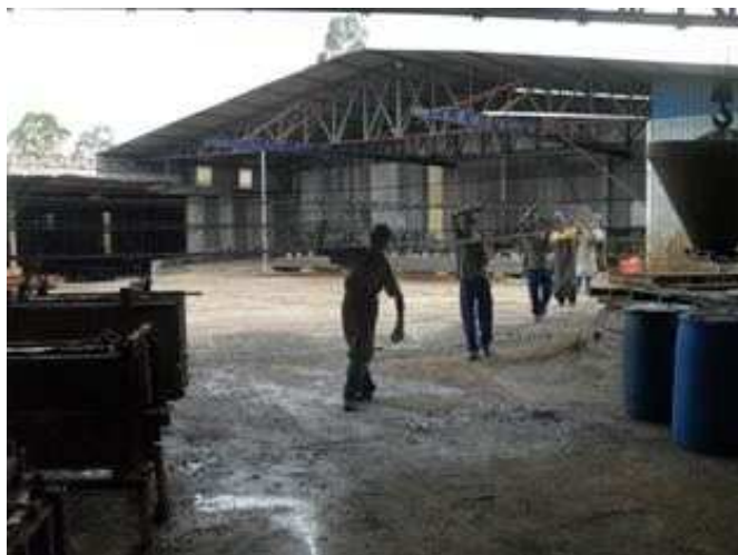
Fotografia 10 – Transporte manual de armaduras Fonte: Autoria Própria
