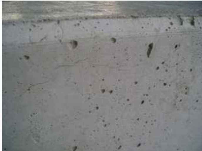
Fotografia 15 – Bolhas superficiais Fonte: Autoria própria
