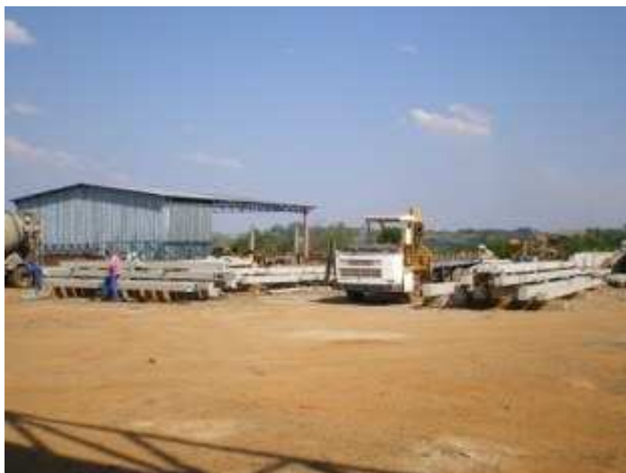
Fotografia 14 – Depósito de peças recém concretadas: incidência direta do sol Fonte: Autoria própria
