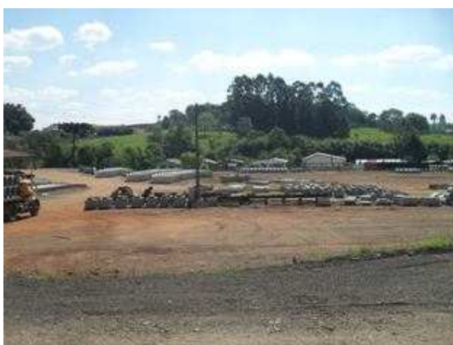
Fotografia 9 – Cura ambiente das peças pré-moldadas Fonte: Autoria Própria
