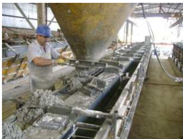
Fotografia 11 – Forma estacionária: concreto transportado por ponte rolante Fonte: Autoria própria
