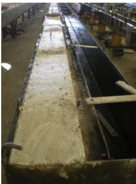
Fotografia 7 – Concreto no estado endurecido Fonte: Autoria Própria
