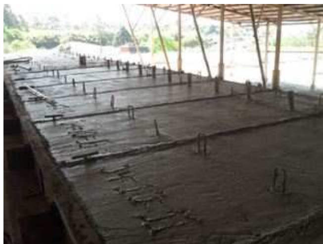
Fotografia 19 – Concretagem das galerias Fonte: Autoria própria
