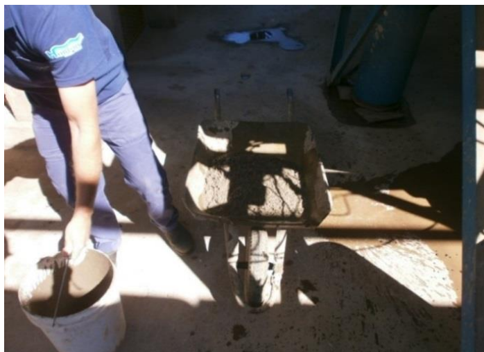
Figura 7: Concreto sendo transferido do balde para o carrinho de mão Fonte: Autorial própria
