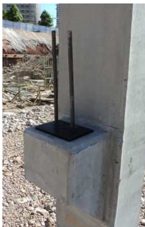
Figura 15 - Aparelho de apoio do consolo Fonte: Rech, 2014
