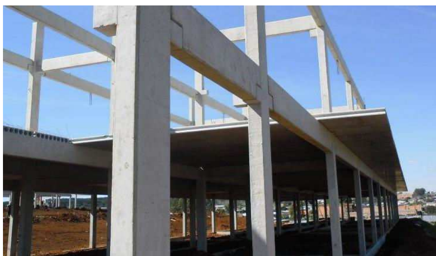
Figura 20 - Lajes alveolares em balanço Fonte: Rech, 2014.
