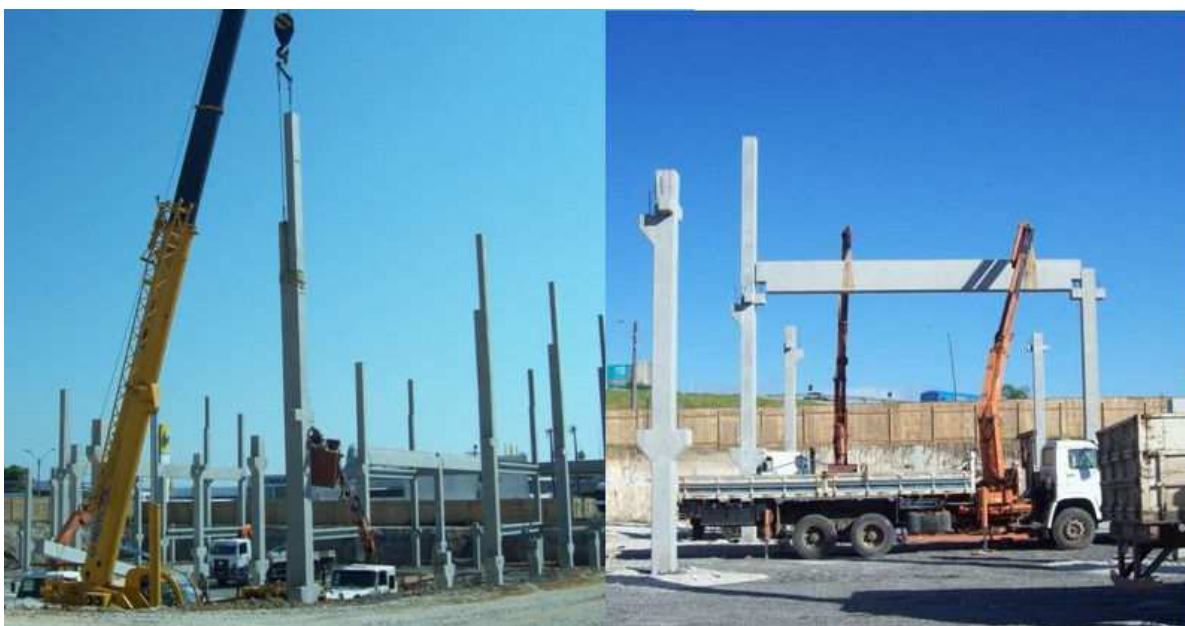
Figura 22 - Montagem de Pilar e Viga Fonte: Rech, 2014.
