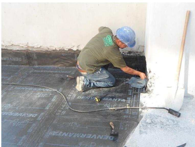
**Figura 8 – Compressão da manta contra a parede para fixação.**
