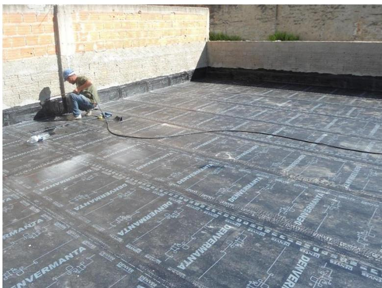
**Figura 1 – Impermeabilização com manta asfáltica.**
