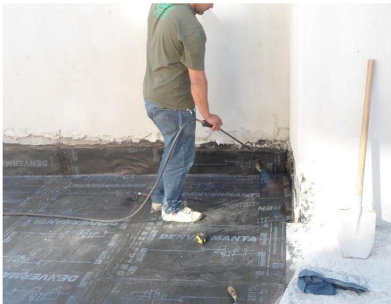
**Figura 7 – Aquecimento da manta asfáltica**
