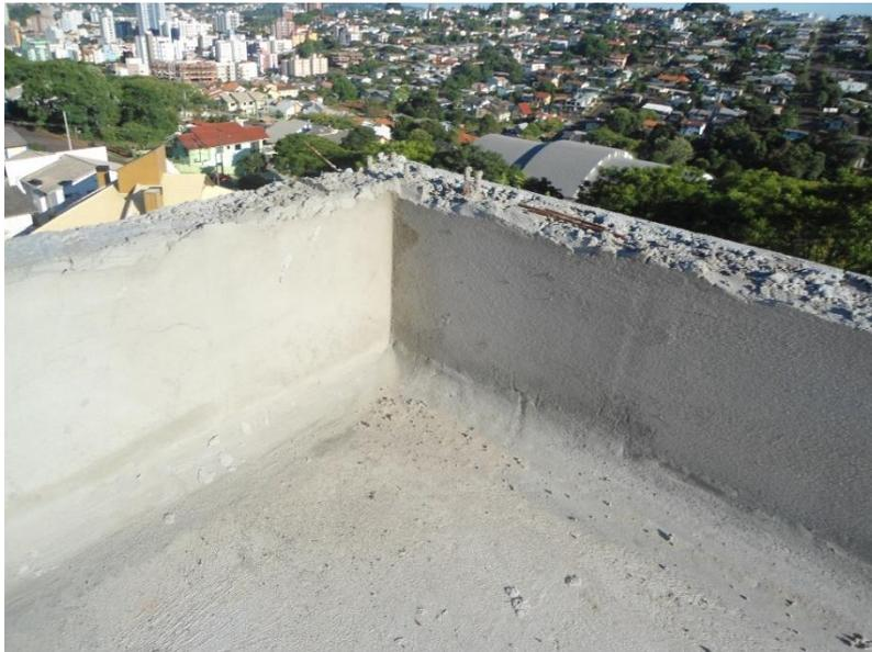
**Figura 5 – Arredondamento de cantos internos.**
