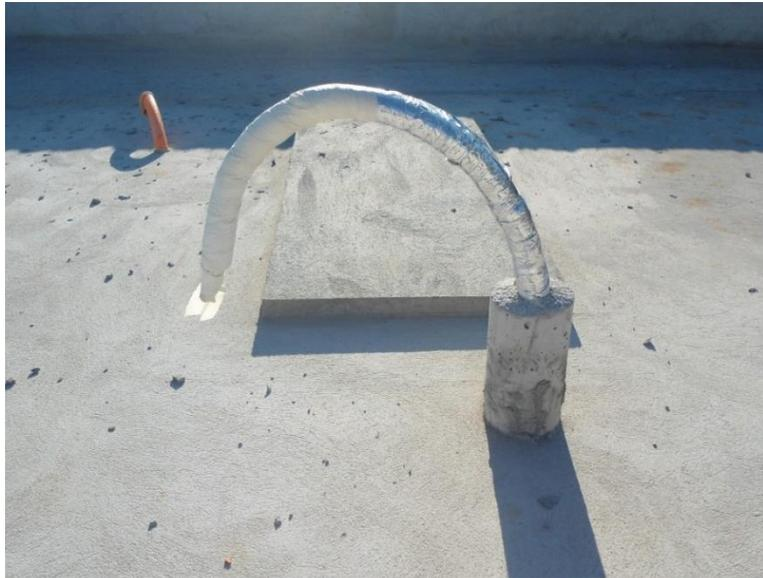
**Figura 2 – Tubulação de ar-condicionado**
