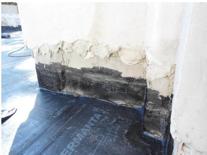
**Figura 6 – Embutimento da manta no emboço da parede lateral.**
