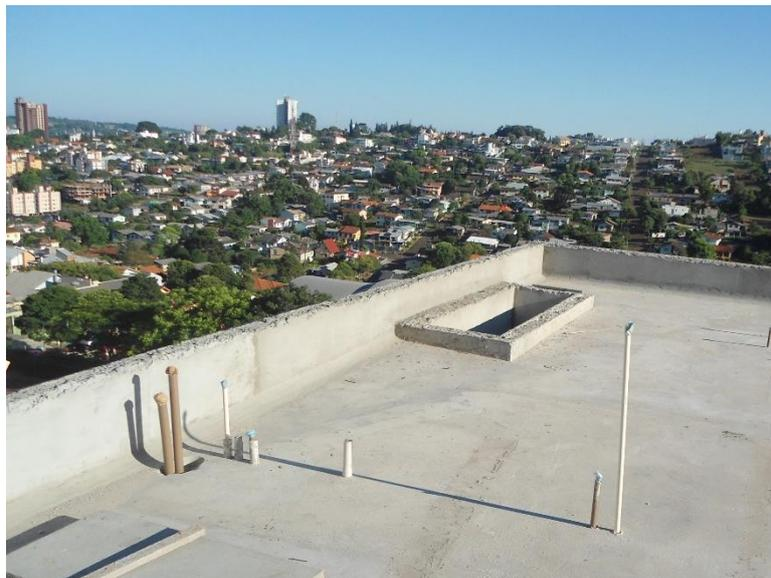
**Figura 3 – Tubulações hidrossanitárias**
