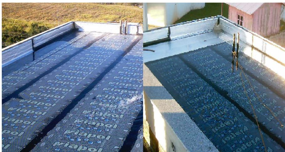
**Figura 9 – Teste de estanqueidade**
