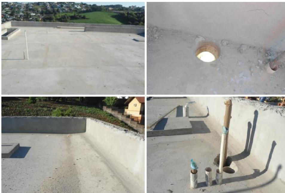
**Figura 16 – Preparação da laje para a impermeabilização**
