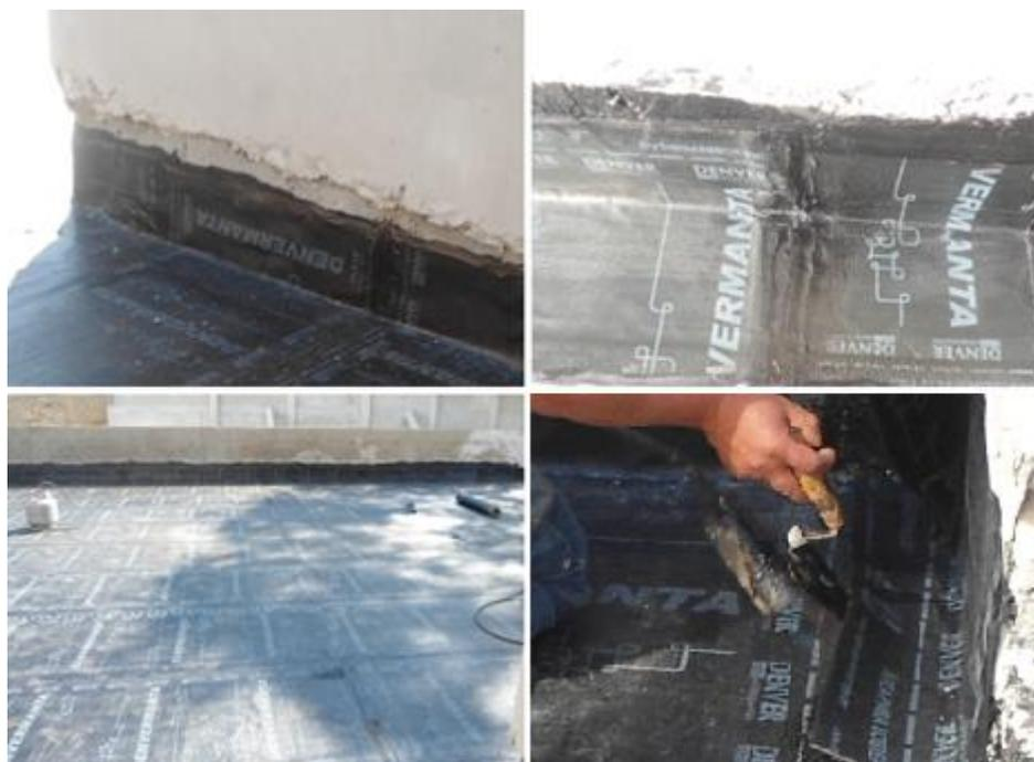
**Figura 17 – Impermeabilização com manta asfáltica**
