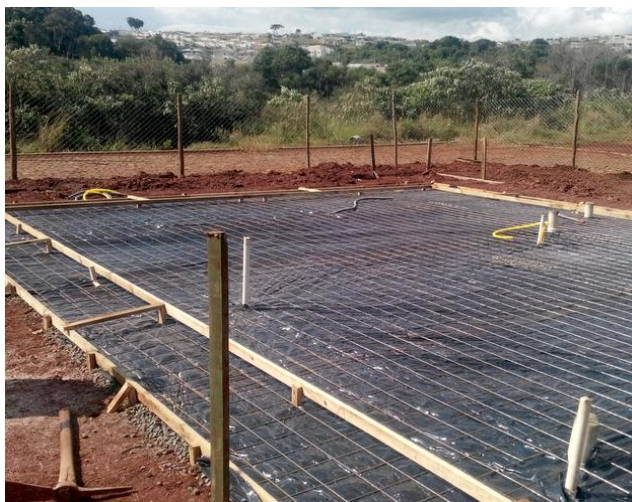
Figura 32 – Armadura do radier Fonte: Autoria Própria (2014).
