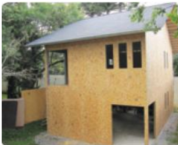
Figura 18 – Fechamento com OSB Fonte: LP Building Products (2011, p.7).
