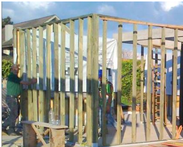
Figura 36 – Estrutura dos painéis de wood frame Fonte: Autoria Própria (2014).
