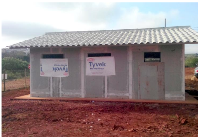
Figura 47 – Fechamento externo com placa cimentícia Fonte: Autoria Própria (2014).
