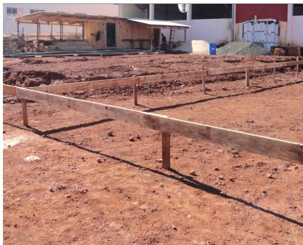
Figura 30 – Locação de obra Fonte: Autoria Própria (2014).
