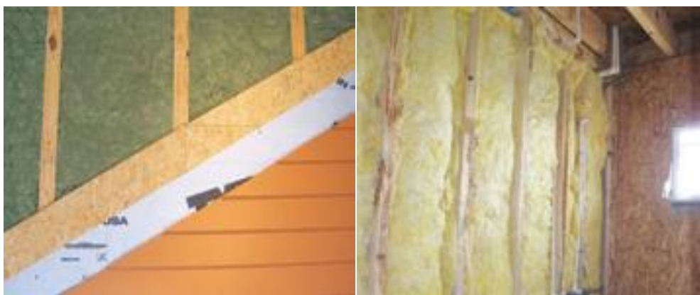
Figura 14 – Isolamento termoacústico em painéis Fonte: LP Building Products (2011, p.31).
