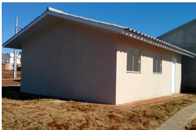
Figura 55 – Limpeza final da obra Fonte: Autorial Própria (2014).
