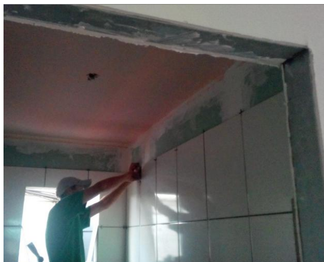
Figura 53 – Colocação de azulejo Fonte: Autoria Própria (2014).
