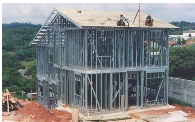
Figura 1 – Estrutura em steel frame
