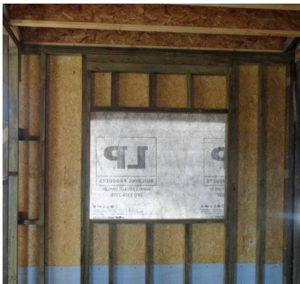
Figura 50 – Contraventamento da ossatura de madeira Fonte: Autoria Própria (2014).
