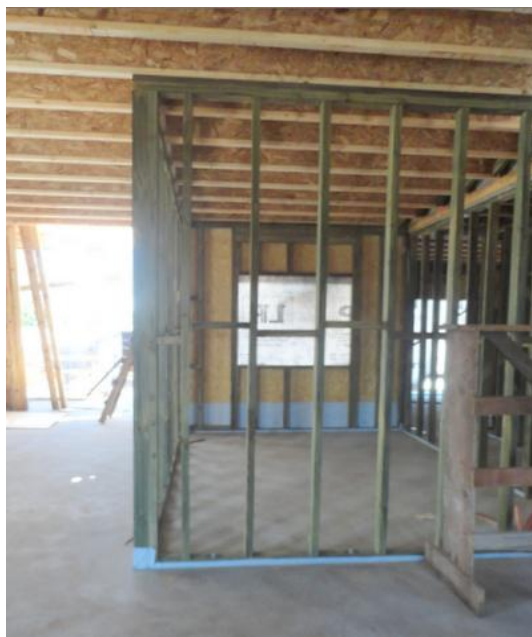
Figura 37 – Ossatura de madeira Fonte: Autoria Própria (2014).
