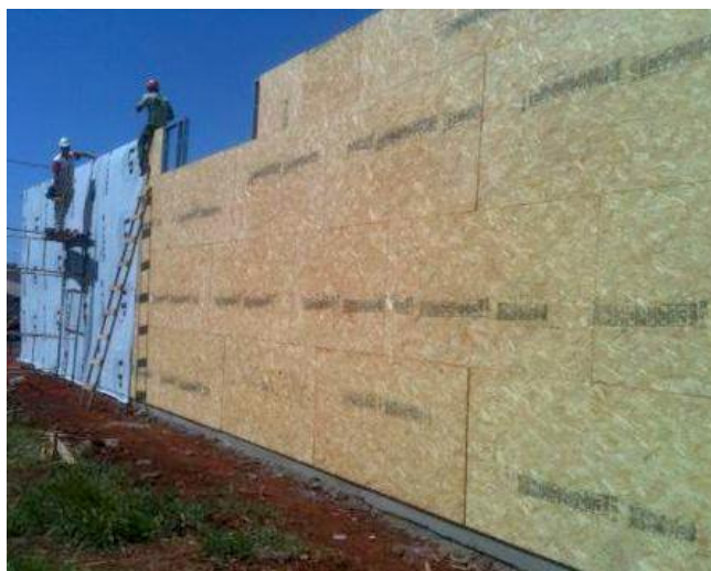
Figura 49 – Fechamento externo com OSB Fonte: Aatoria Própria (2014).
