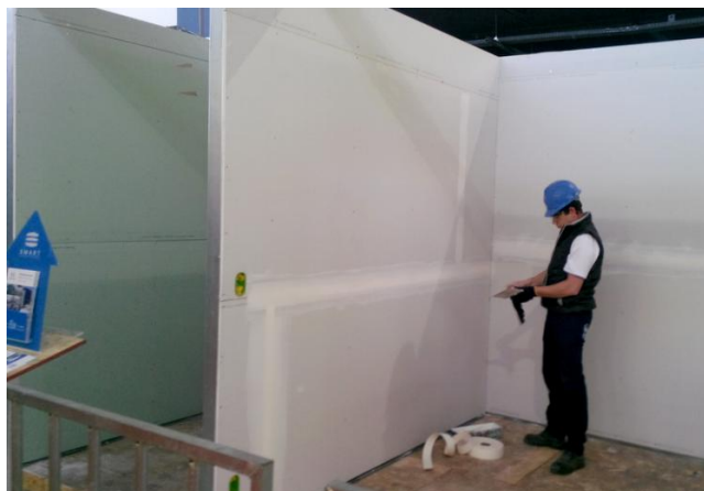
Figura 48 – Fechamento com gesso acartonado Fonte: Aatoria Própria (2014).
