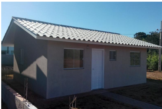
Figura 52 – Revestimento externo Fonte: Autoria Própria (2014).
