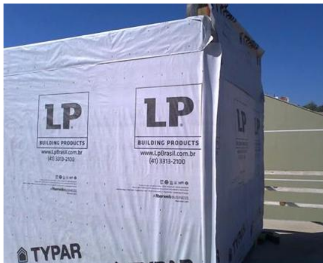
Figura 38 – Envolvimento da edificação pela membrana hidrófuga Fonte: Aatoria Própria (2014).
