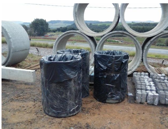
Figura 33 - Sistema de Encamisamento de Face Superior Aberta Fonte: Autoria Própria
