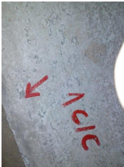
Figura 29 – Bolhas com Diâmetro Superior a 10 mm e Profundidade Superior a 5 mm Fonte: Autoria Própria
