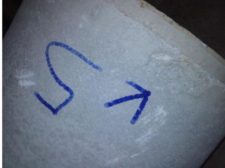
Figura 25 – Defeito de Acabamento na Borda Superior do Tubo Número 5 Fonte: Autoria Própria
