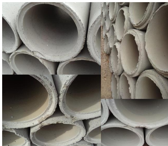
Figura 41 – Machos e Fêmeas Quebrados Durante o Empilhamento para Vários Diâmetros Fonte: Autoria Própria
