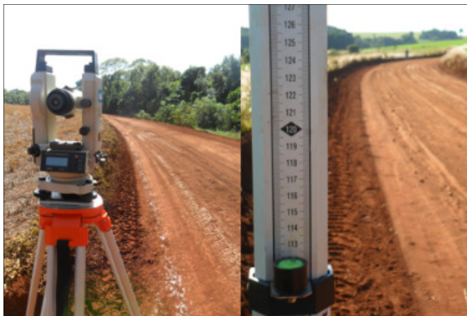
Figura 14 - Levantamento Topográfico FONTE: Aatoria Própria (2014).
