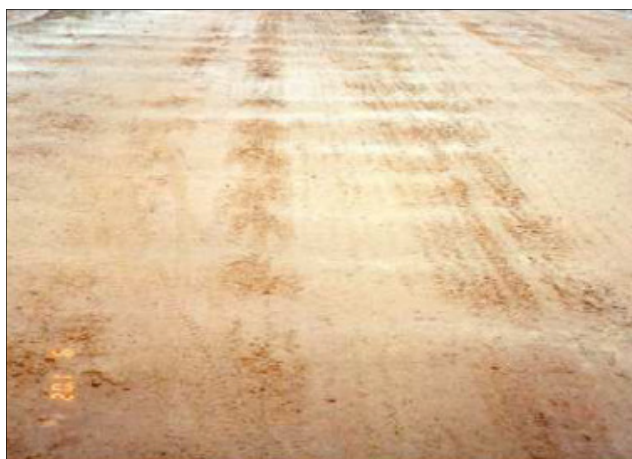
Figura 2 – Defeito: Ondulações FONTE: Techio (2009).
