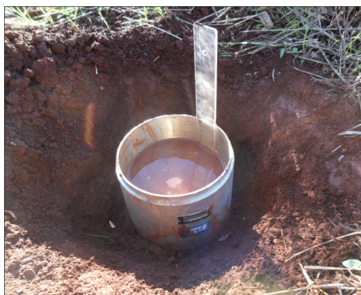
Figura 24 – Ensaio de infiltração FONTE: Autoria Própria (2014).
