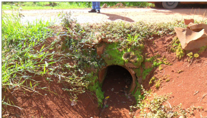
Figura 38 - Bueiro existente no trecho estudado FONTE: Autoria Própria (2014).
