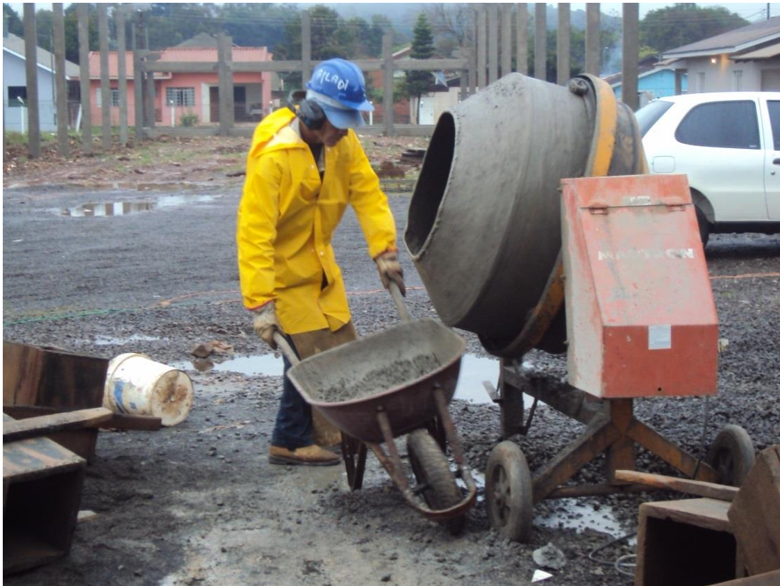
Figura 1 - Trabalhador fazendo uso de alguns EPIs no momento da concretagem Fonte: Autoria própria (2013)
