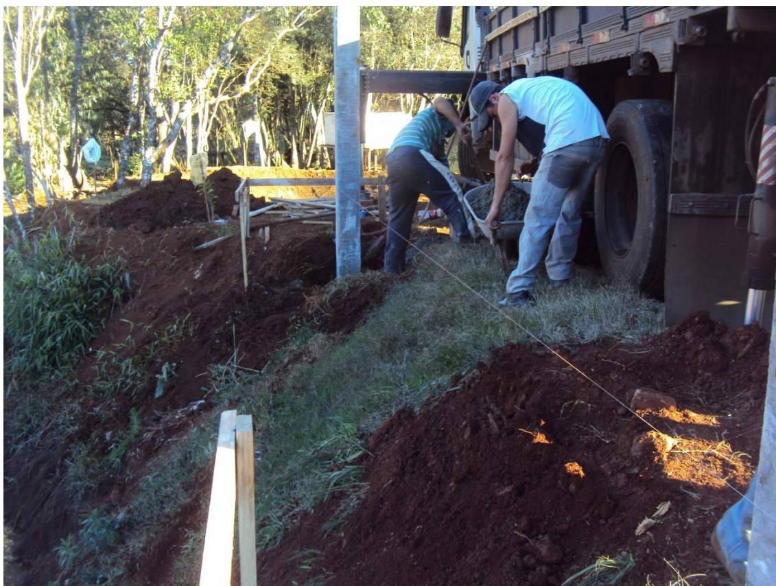
Figura 8 - Trabalhadores realizando uma concretagem in loco com pouco espaço de trabalho
