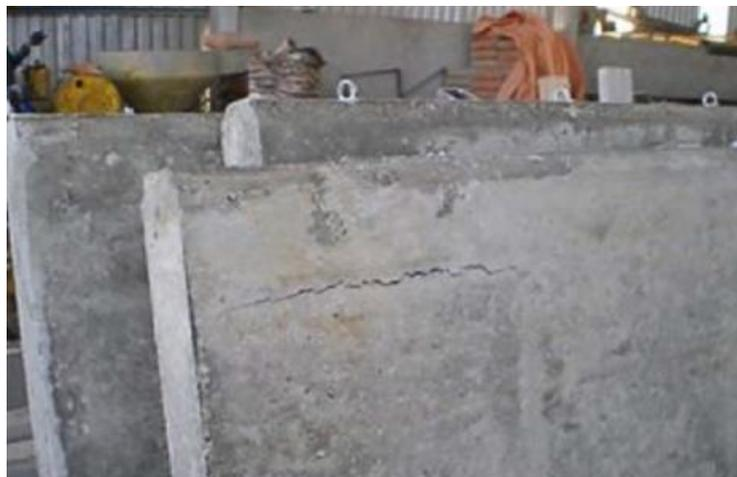
**Figura 06 - Fissuras na superfície do elemento pré-moldado
