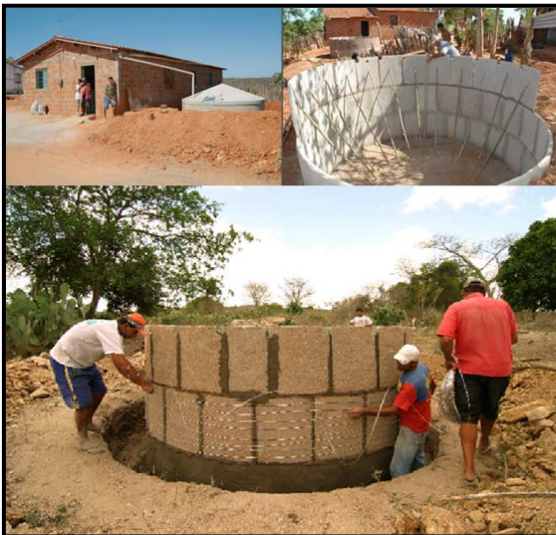
Figura 3 - Cisterna de placas de concreto
