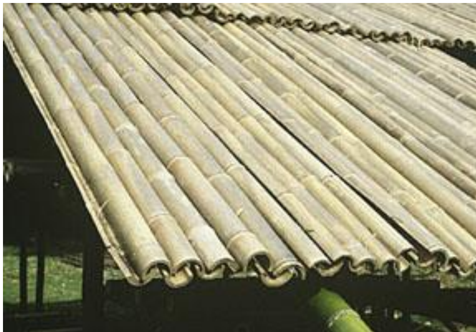
Figura 13 – Telhado de Bambu Fonte: Vasconcellos (2015)
