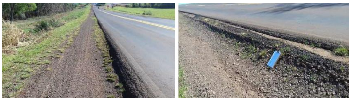
Figura 25: Degraus entre pista e acostamento Fonte: Autoria própria (2018).
