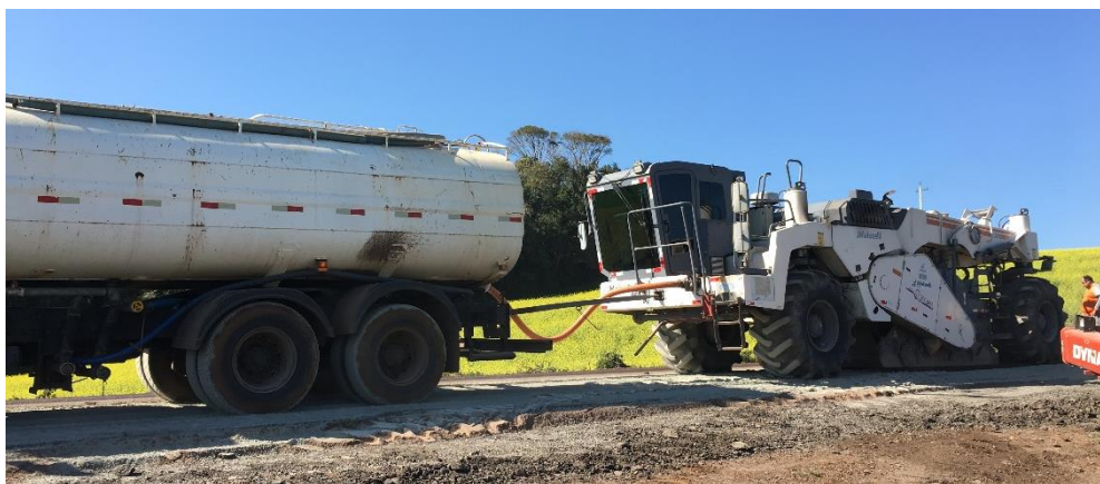
Figura 13: Recicladora realizando o corte do pavimento Fonte: Autoria própria (2018).
