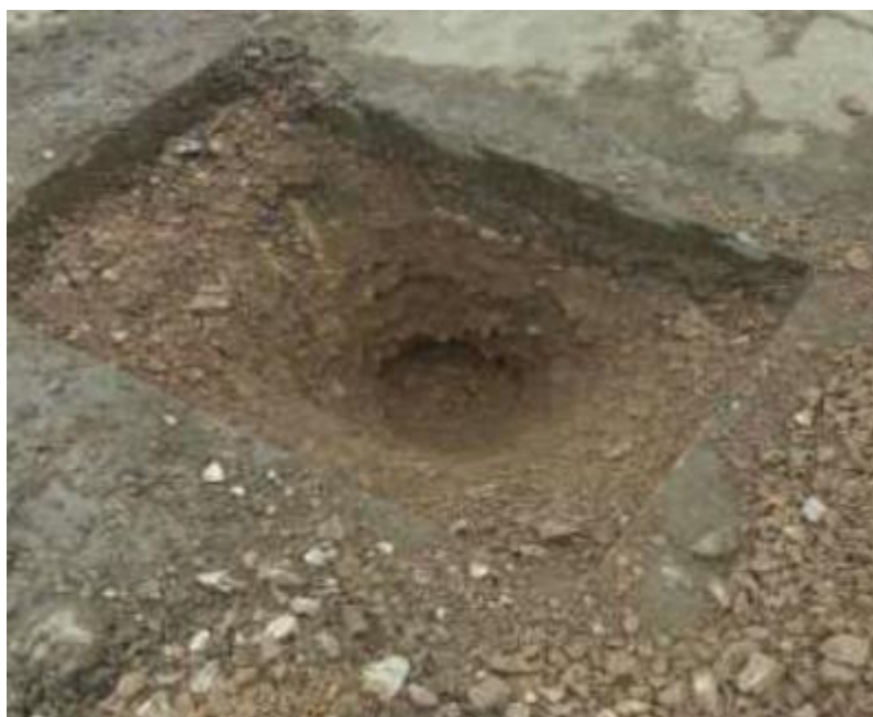
Figura 6: Abertura de poço de sondagem Fonte: Autoria própria (2018).
