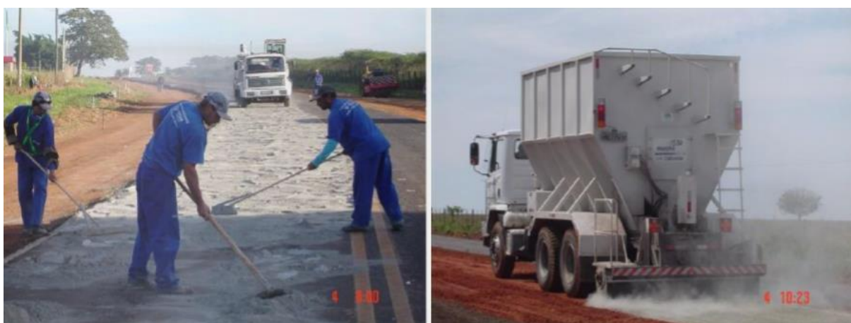
Figura 8: Aplicação do agente estabilizante: manual (esq.) e mecânica (dir.) Fonte: OLIVEIRA (2007).
