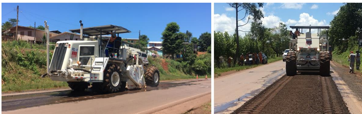
Figura 11: Corte do pavimento (esq.) e material a ser coletado (dir.) Fonte: Autoria própria (2018).
