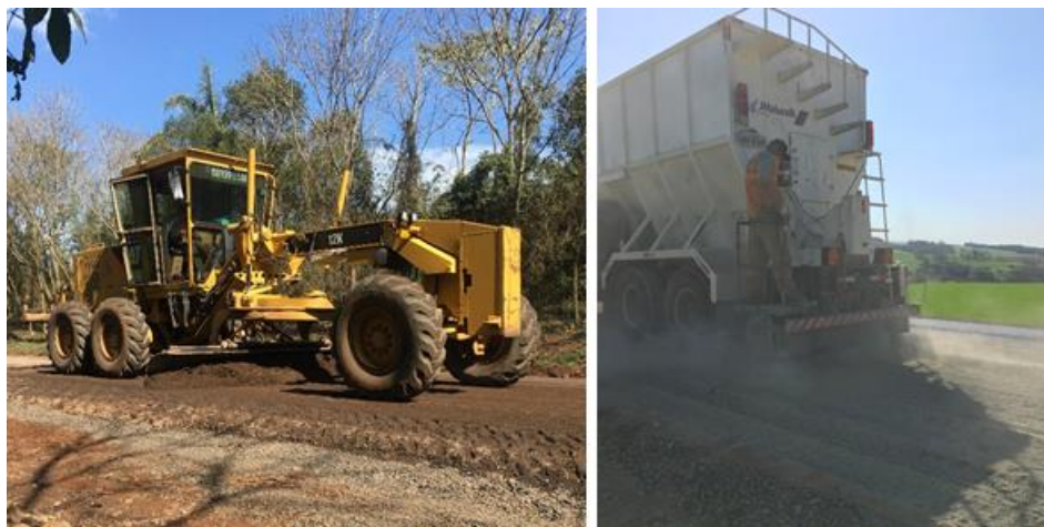
Figura 12: Uniformização do agregado miúdo (esq.) e distribuição de cimento (dir.) Fonte: Autoria própria (2018).
