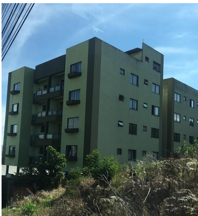
Figura 23: Edifício 11 Fonte: Autor (2018).
