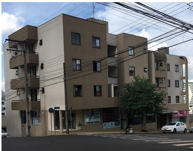
Figura 13: Edifício 1 Fonte: Autor (2018).
