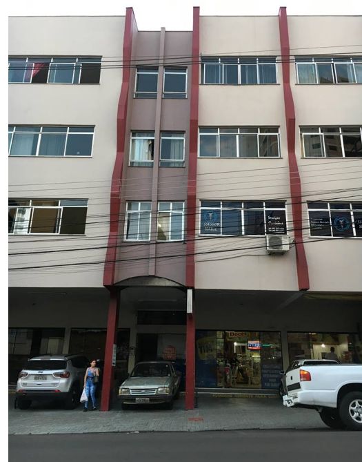
Figura 24: Edifício 12 Fonte: Autor (2018).
