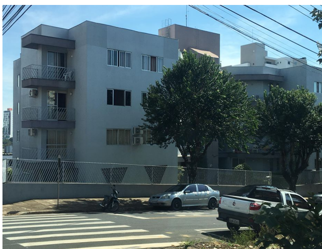
Figura 15: Edifício 3 Fonte: Autor (2018).
