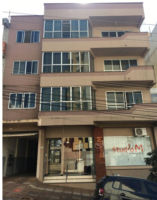
Figura 14: Edifício 2 Fonte: Autor (2018).
