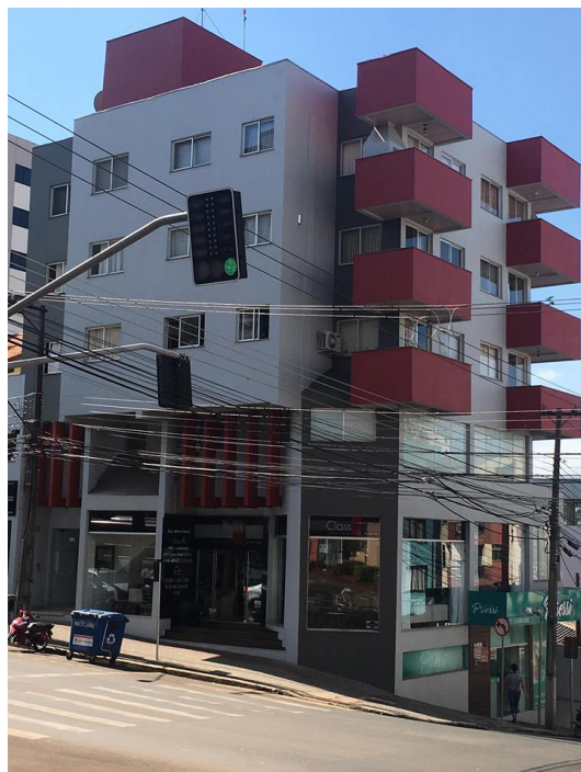
Figura 22: Edifício 10 Fonte: Autor (2018).
