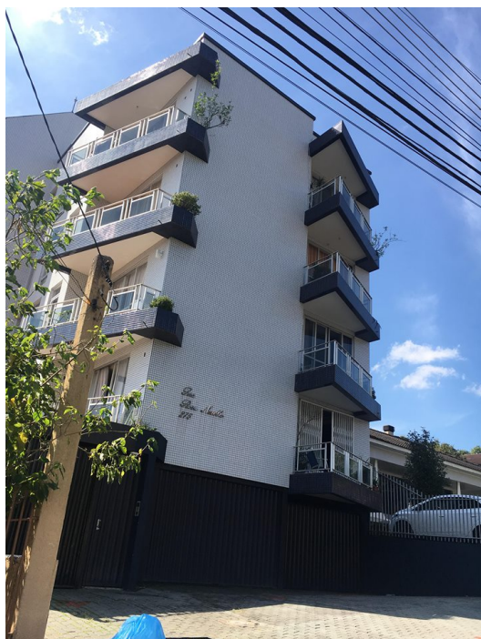
Figura 21: Edifício 9 Fonte: Autor (2018).
