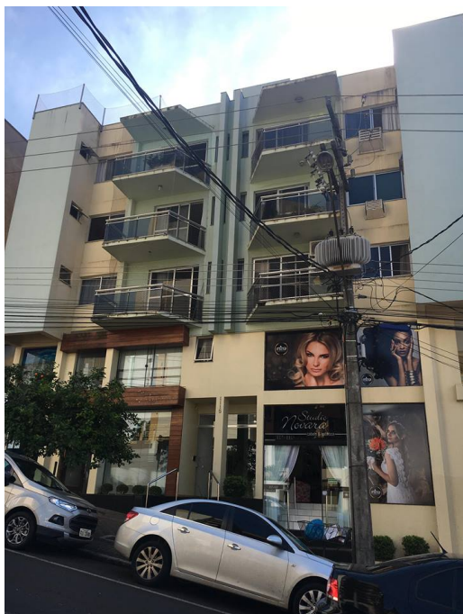
Figura 17: Edifício 5 Fonte: Autor (2018).
