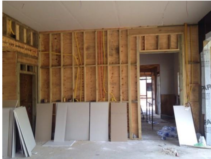
Figura 21 - Passagem das tubulações no wood frame Fonte: Condomínios fechados residenciais (2018).
