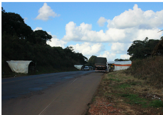
Figura 3 – Vista da PRT 280, fotografada nas entrevistas realizadas no ano de 2015.
