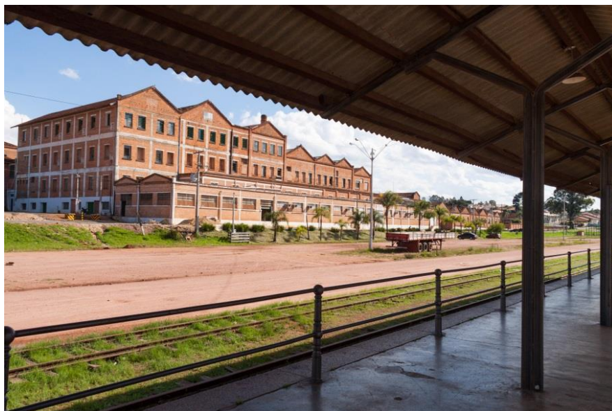
Figura 67 – Matarazzo – antiga nave ainda existente– ATUAL
