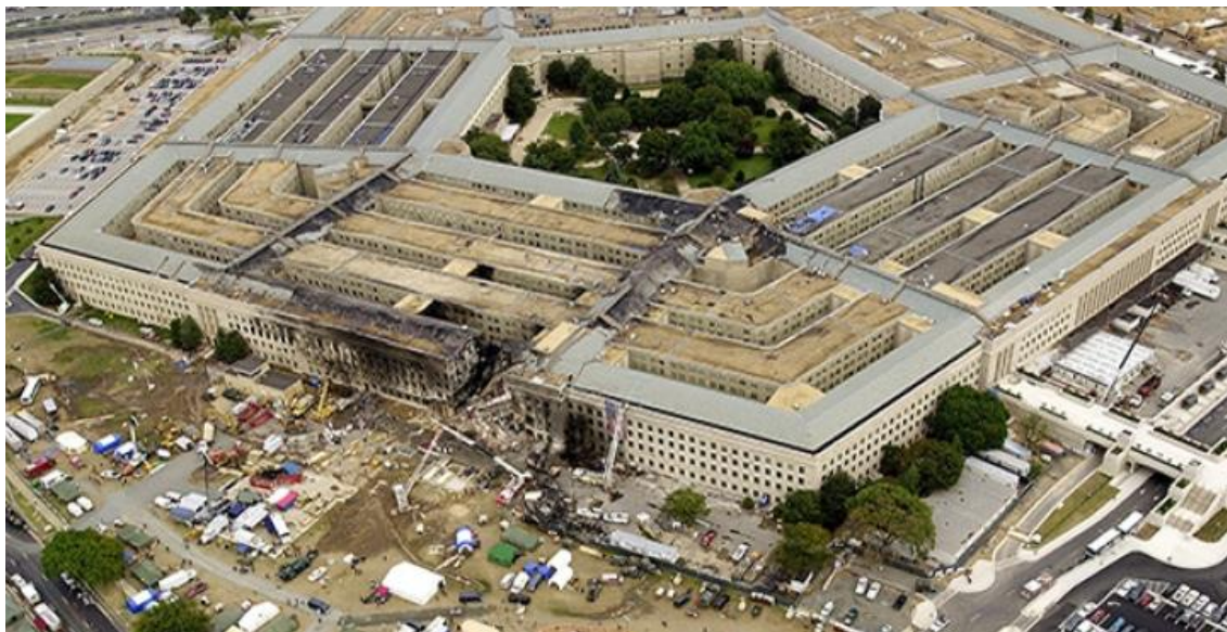
Figura 5 – Ataque terrorista ao Pentágono – 2001 – durante as obras de retrofit
