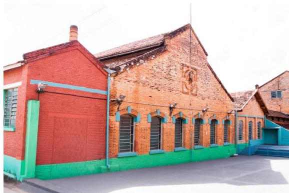
Figura 63 – Matarazzo – naves interditadas pelo projeto Casulo – ATUAL
