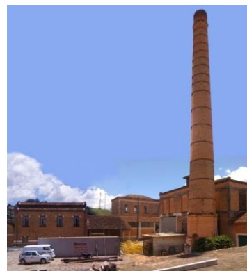
Figura 59 – Matarazzo – acesso externo subutilizado - ATUAL
