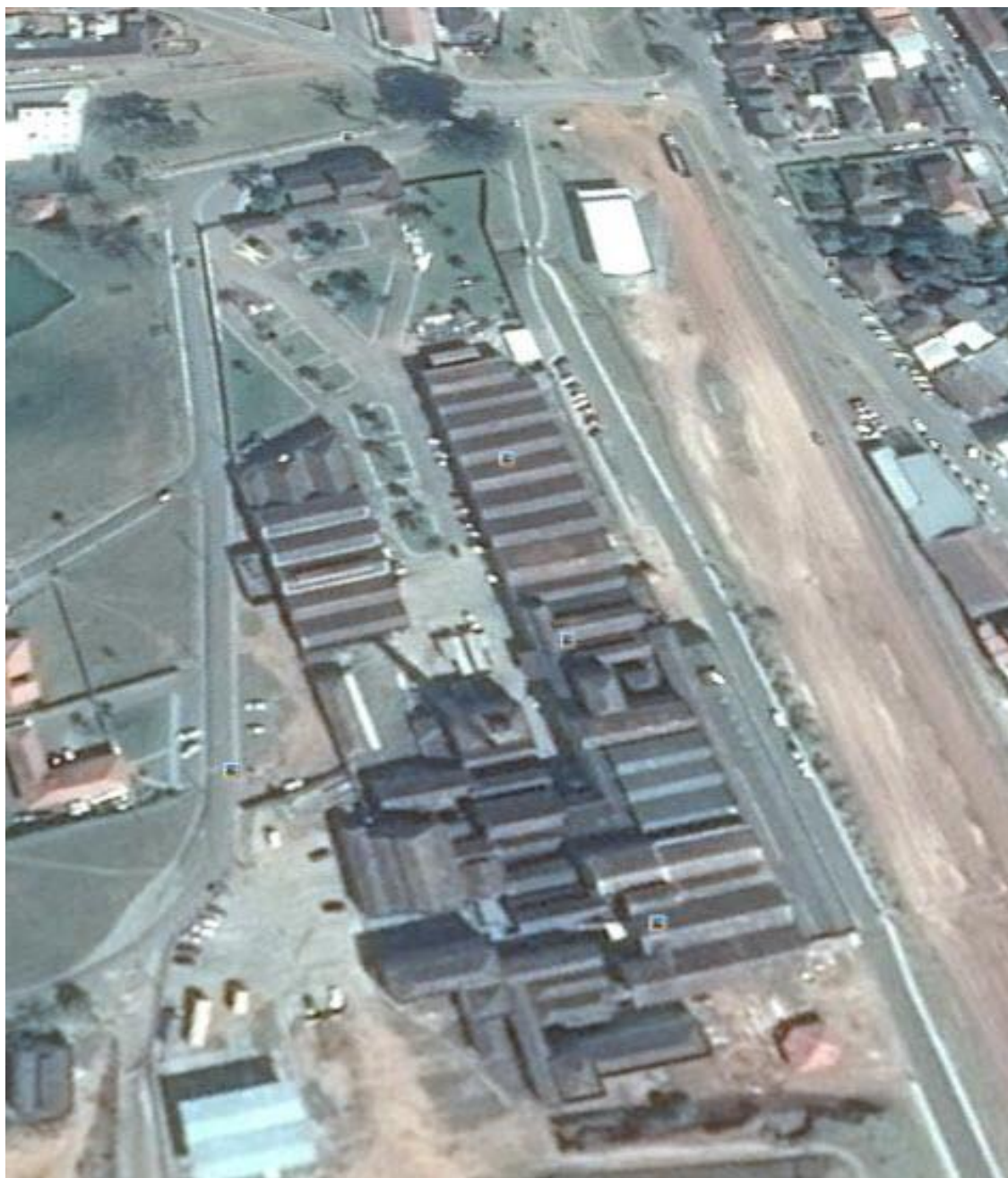
Figura 69 – Matarazzo – vista aérea – ATUAL
