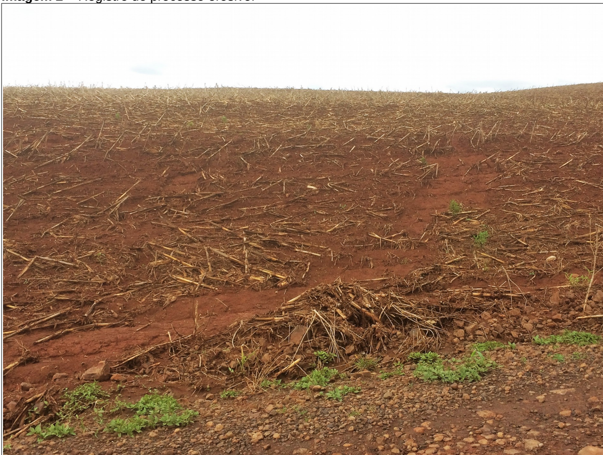
Imagem 2 – Registro de processo erosivo.
