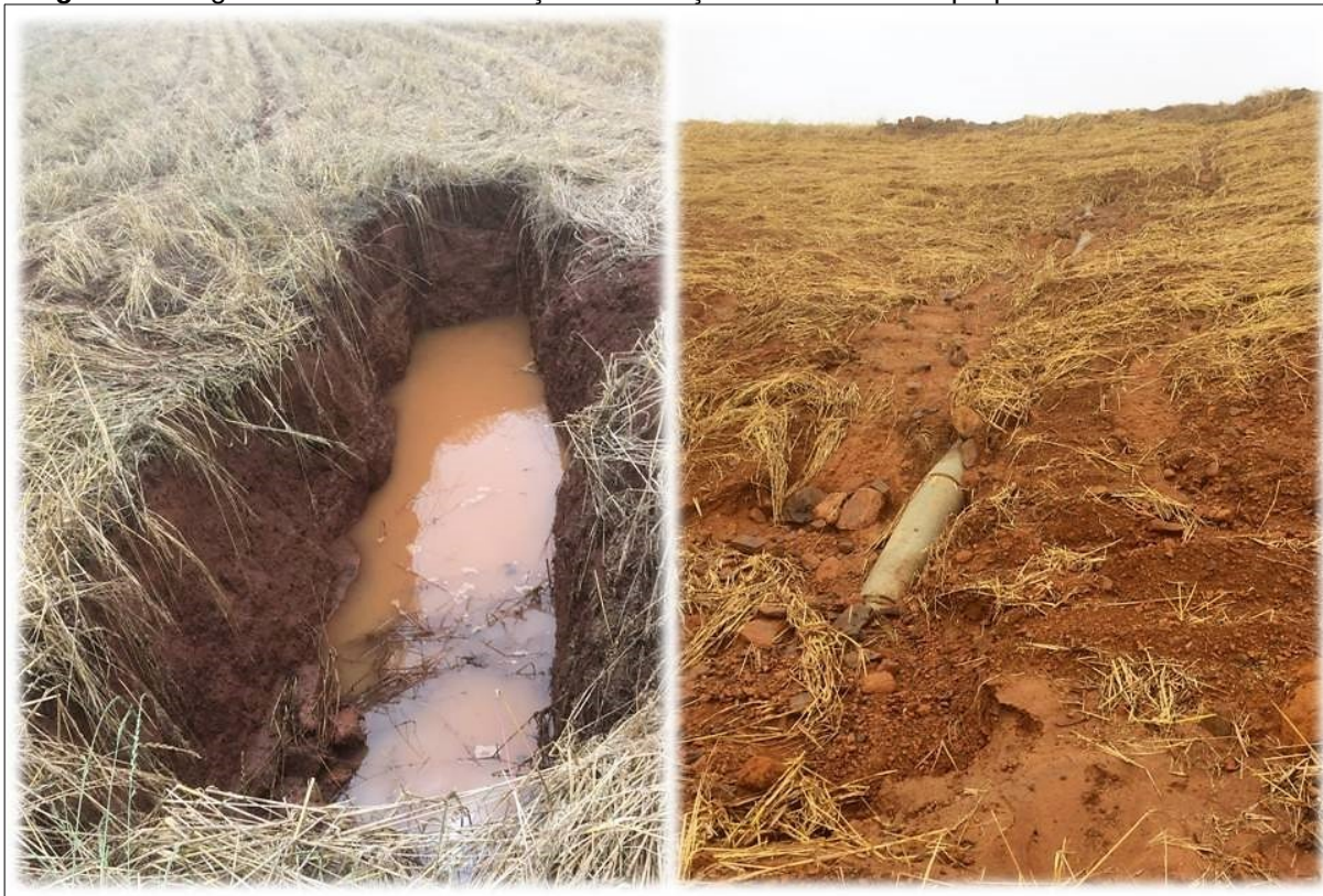
Imagem 1 – Registros de caixa de retenção e tubulação subterrânea na propriedade 11.
