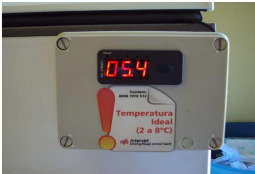
**Figura 4 – Termostato do refrigerador de armazenamento das vacinas.**
