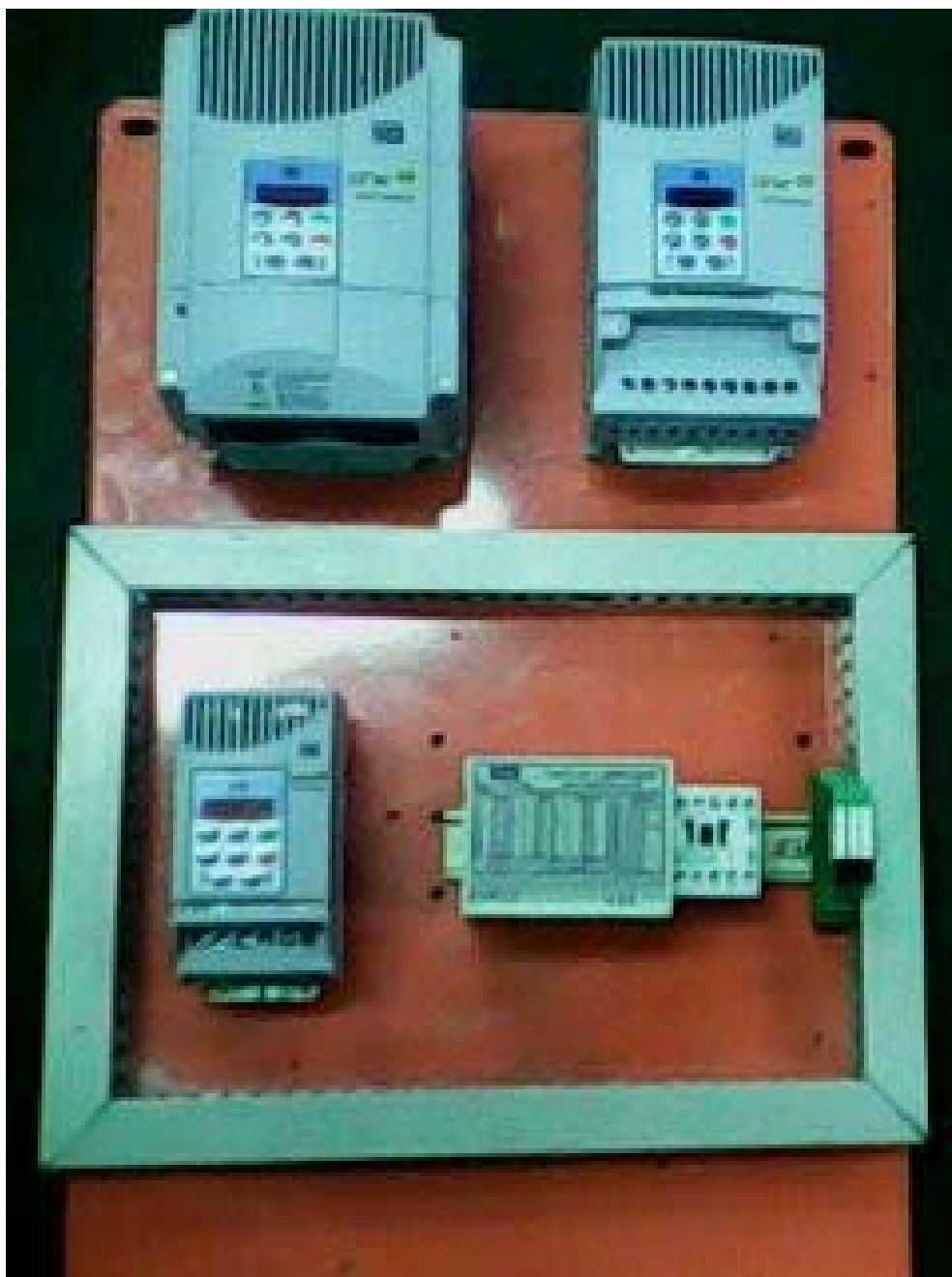
Figura 22: Início da montagem do painel elétrico.
