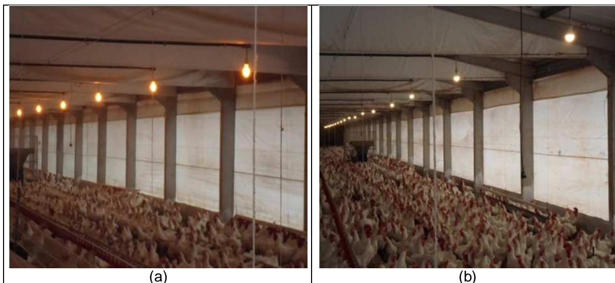
Figura 7 – Lâmpadas vapor de sódio (a) e lâmpadas LED (b) Fonte: A autora.
