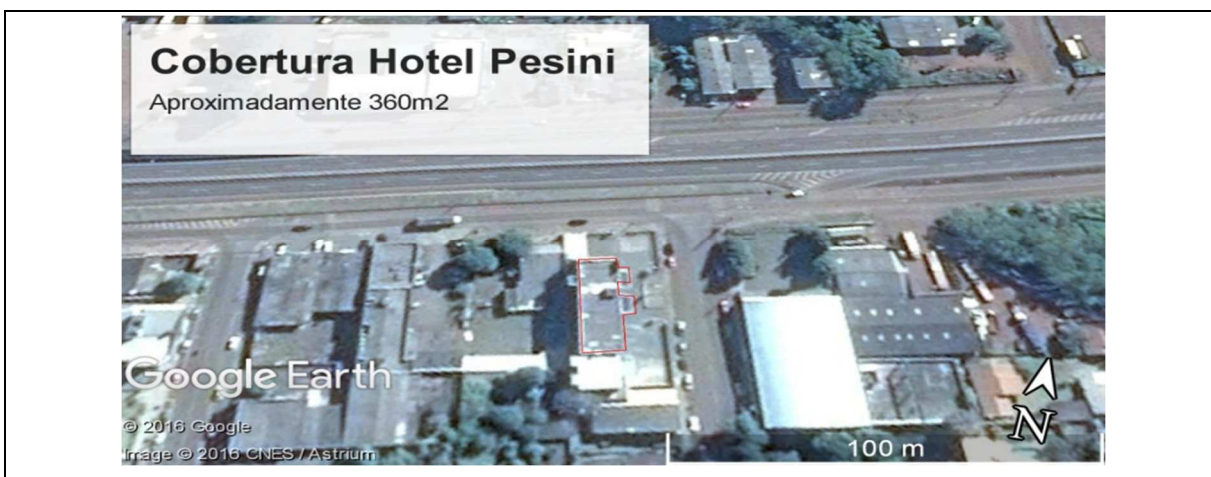
Figura 15 – Vista do telhado Fonte: Google Earth (2016)
