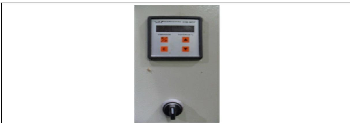
**Figura 14 – Controlador e manopla liga/desliga**
