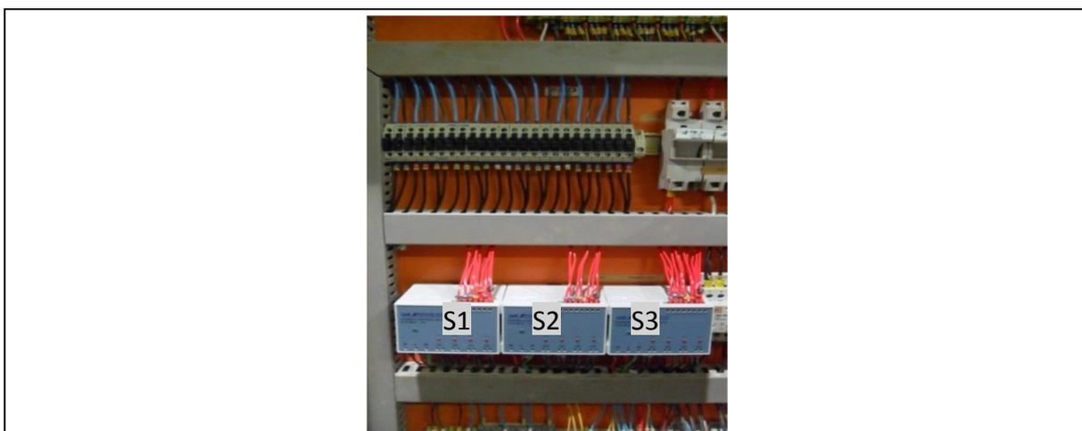
**Figura 13 – Módulos de controle e bornes fusíveis**
