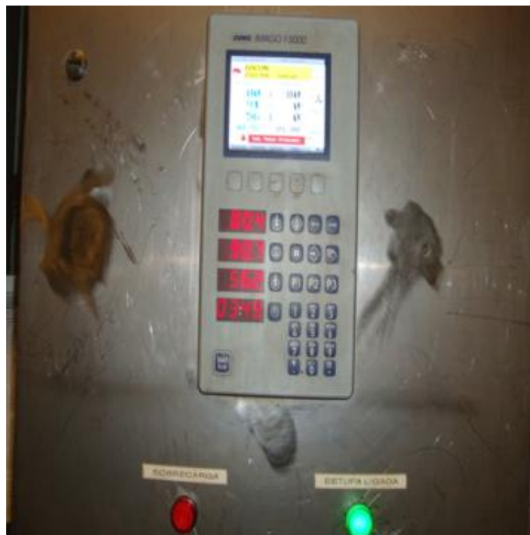
Figura 29 – Vista Frontal Externa do Novo Painel Elétrico
