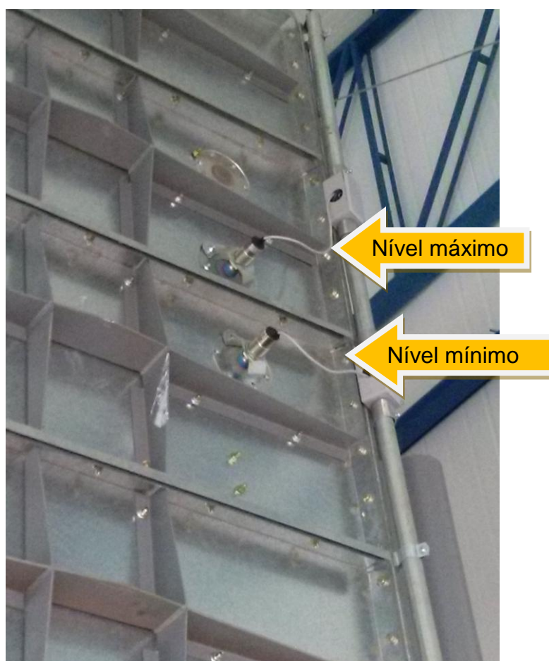
Figura 9 - Sensores de Níveis Superior e Inferior.
