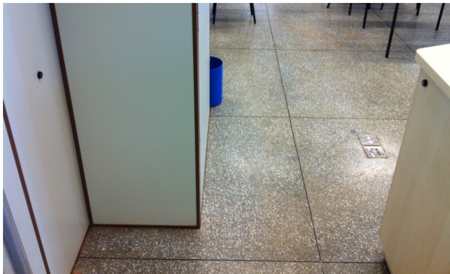
Figura 19: Visualização da instalação do sensor emissor e receptor.
