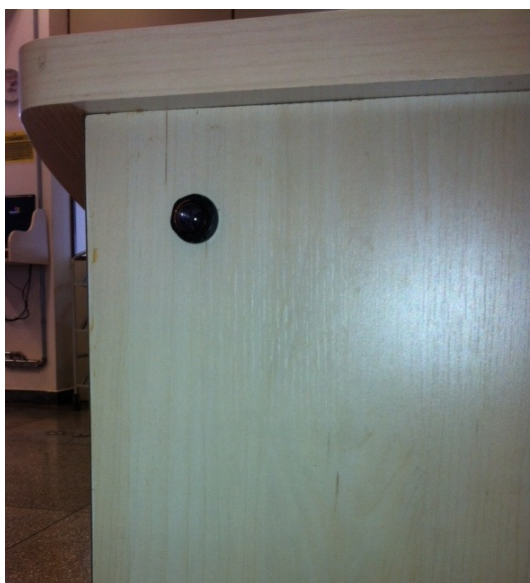
Figura 18: Instalação sensor emissor.
