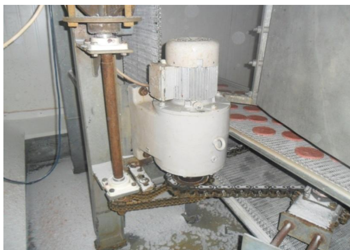
Figura 12 - vista do moto-reductor.
