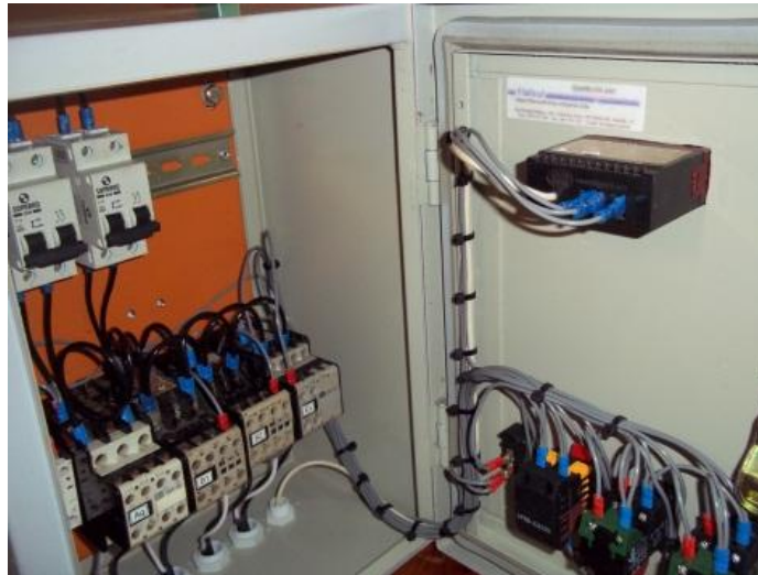
Figura 11 – Painel elétrico.
