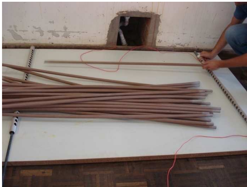
Figura 4 – Encaixar os canos nos furos
