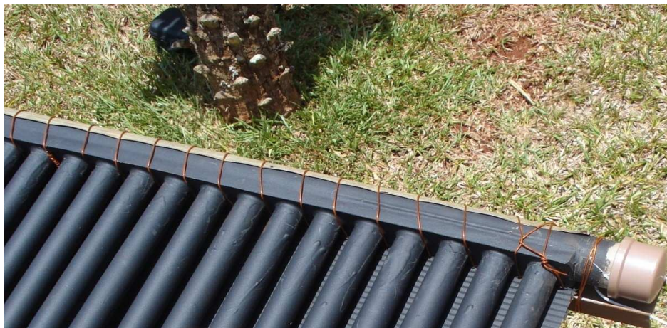
Figura 10 – Detalhe fixação do fundo da placa
