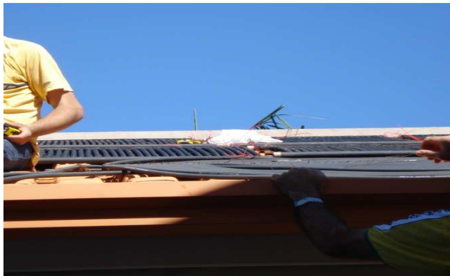
Figura 14 – Fixação das placas no telhado
