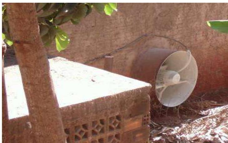
**Figura 3.20 – Parte externa do sistema de ventilação da Sala de Pintura.**
