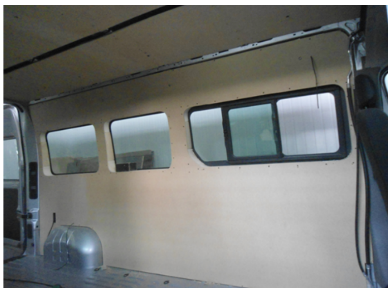
Figura 19-Lateral interna de um veículo revestida com compensado Fotografia-Simoni Castro Lessa Variza, (2013)
