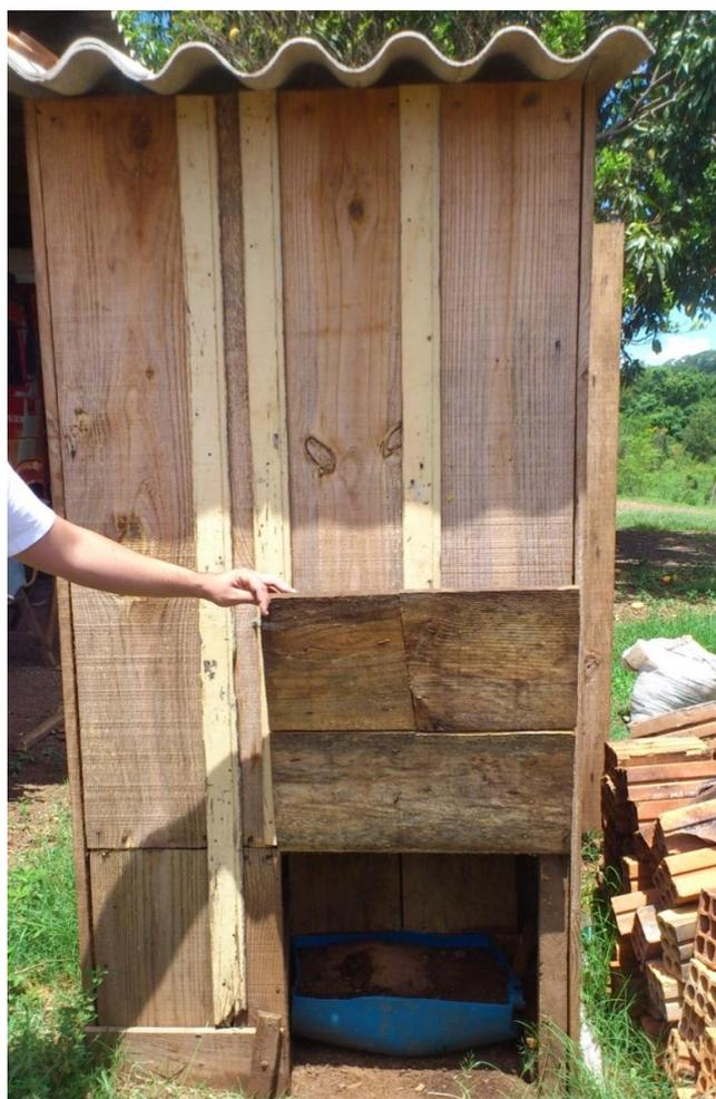
Figura 12 - Vista da parte de trás do banheiro de recipientes móveis implementado
