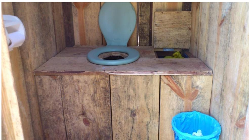
**Figura 11 - Vista interior do banheiro seco de compartimentos móveis implementado na propriedade rural**
