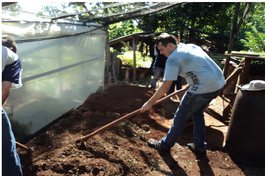
Figura 01 – Área onde foram construídos os canteiros.
