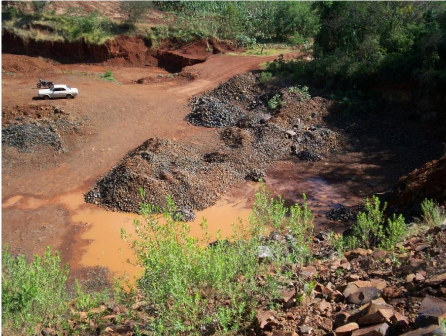
Figura 5 – Bacia de retenção do lodo proveniente das águas das chuvas.
