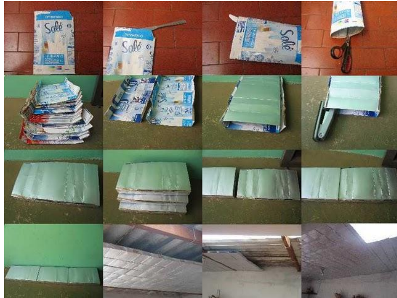
Figura 25 – Esquema de Montagem Tetra Pak Fonte: (TECNOLOGIA SOCIAL, 2011)
