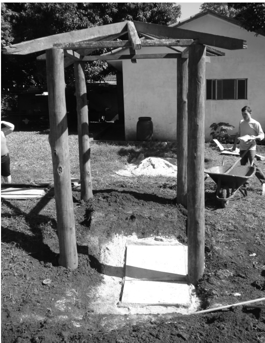
Figura 4: local escolhido pra a construção do bason e estrutura para o telhado 4 águas.
