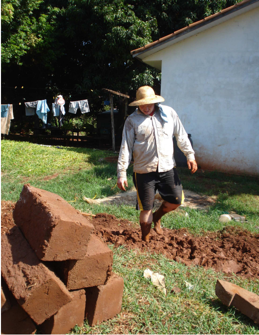
Figura 3: Fabricação de tijolos de adobe
