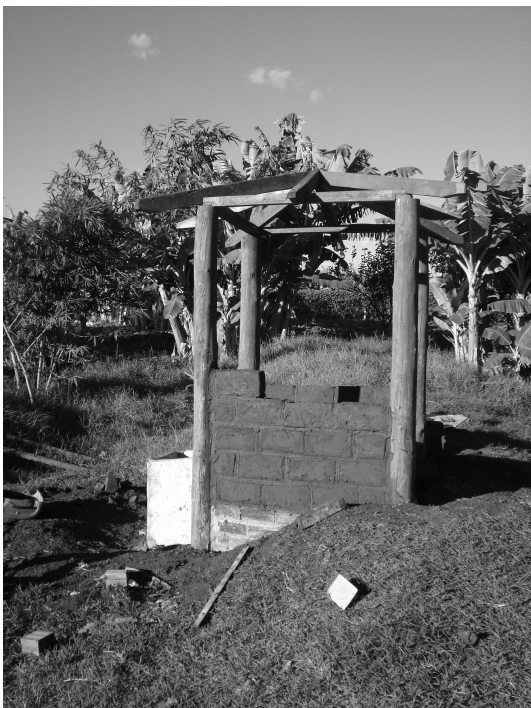
Figura 5: Parede de adobe sendo erguida sobre o alicerce de tijolo de 6 furos.
