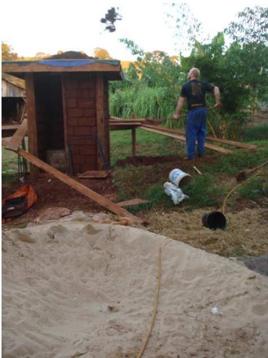
Figura 6: Colocação de solo sobre a camada de areia para finalizar a parte bruta da obra.
